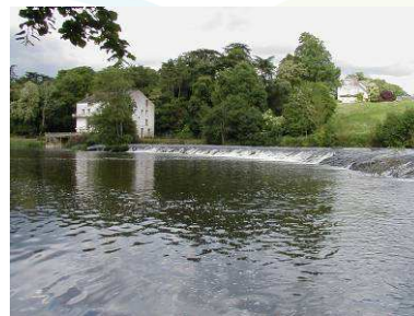
Chaussée du Moulin des Ronces Monnières – Le Pallet
