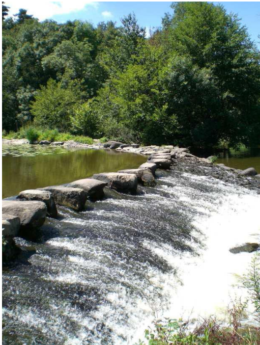
Figure 3 : Seuil du moulin de Gervaux (IIBSN)
