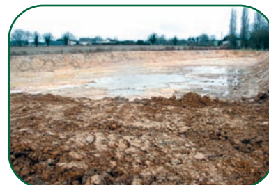
Bassin de rétention
