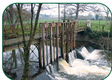
Barrage à vannes levantes sur l'Oudon
