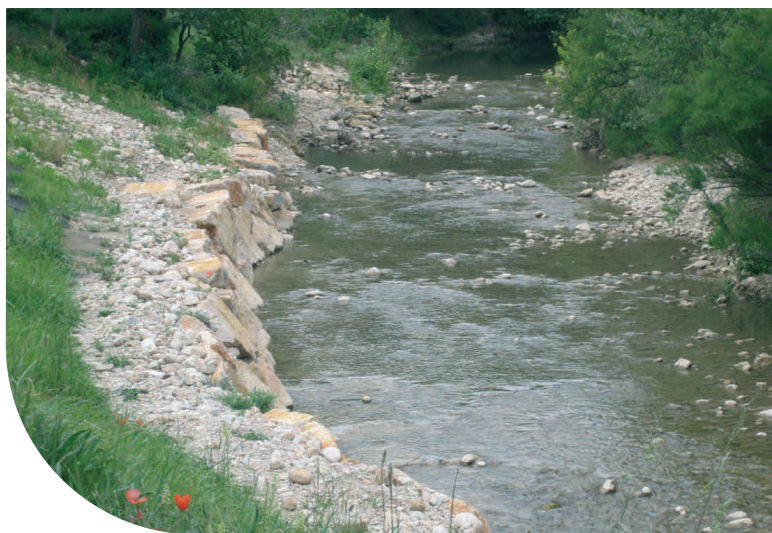
La Nartuby - Aménagement des berges (83)
