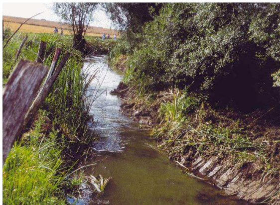
Exemples de retrait sélectif des dépôts avec formation de banquettes
