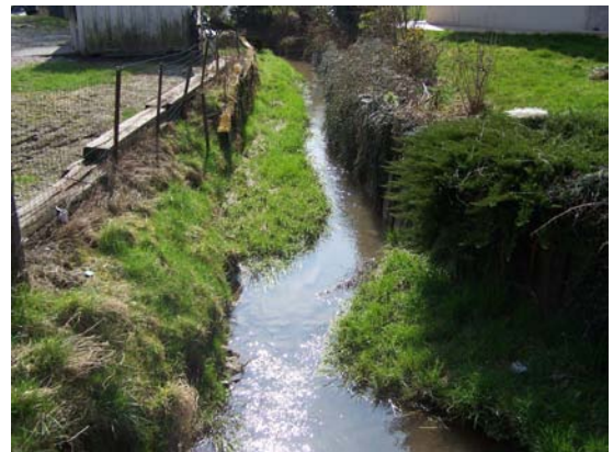
Exemples de retrait sélectif des dépôts avec formation de banquettes
