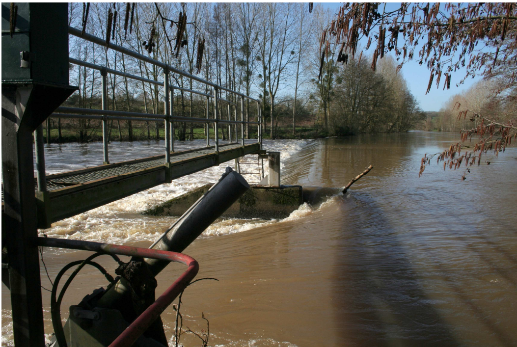
Photo de la chaussée du moulin de Louin (clapet ouvert) en période de fortes eaux (source SMVT – Olivier CONSTANTIN)
