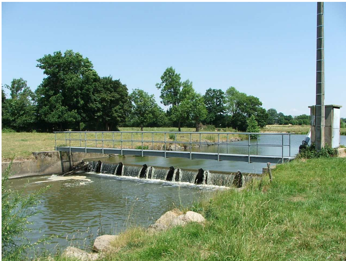
Photo du clapet de la Naulière – Commune de SAINT-ANDRE-SUR-SEVRE – 79 (source IIBSN).
