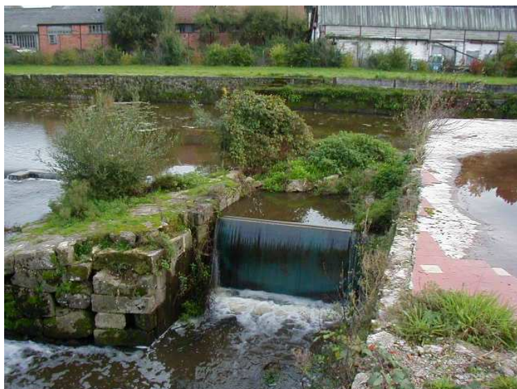
Vanne de décharge de la chaussée de Hucheloup, (source IIBSN).
