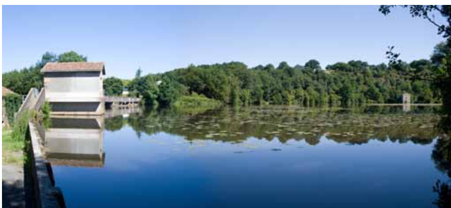
Barrage du Longeron (49) © SR
