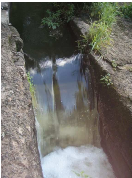
Chaussée des Tanneries – Planche rajoutée pour surélever le niveau de la retenue – Maine 9 Juillet 2012 – SEVRAVAL
