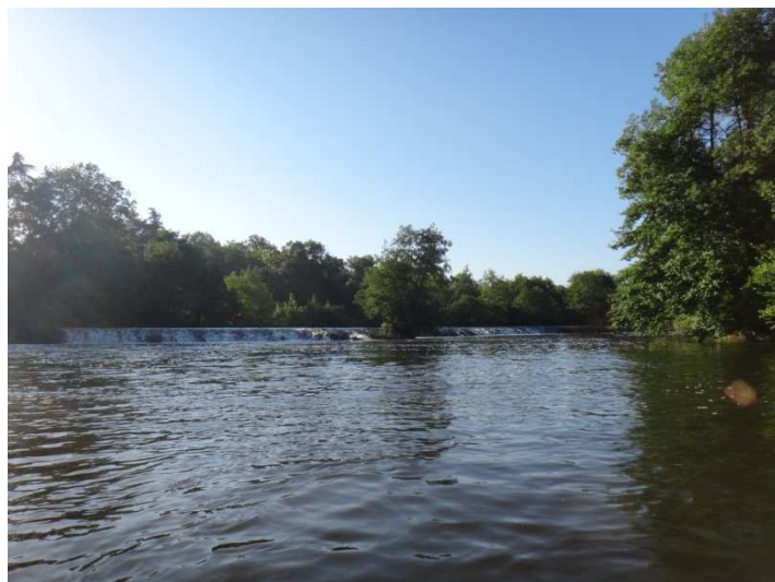
Aval de la chaussée des Ronces – Sèvre nantaise – Septembre 2012 – SCE
