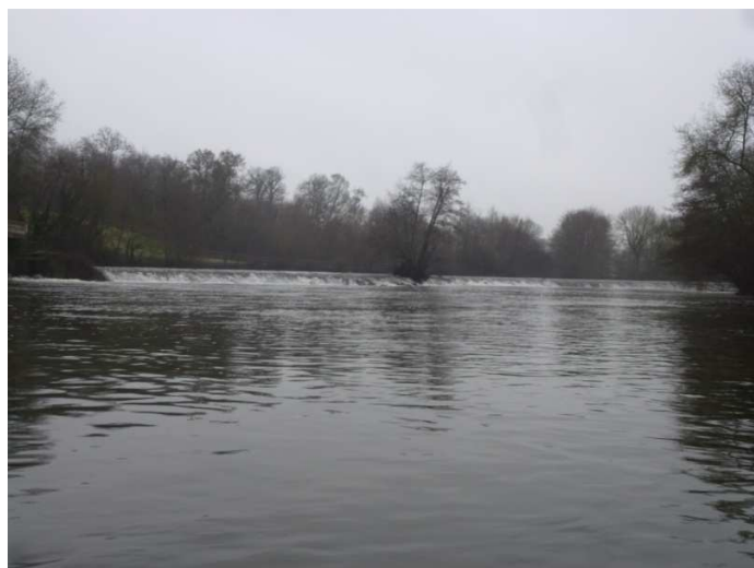
Aval de la chaussée des Ronces – Sèvre nantaise – Janvier 2012 – SCE
