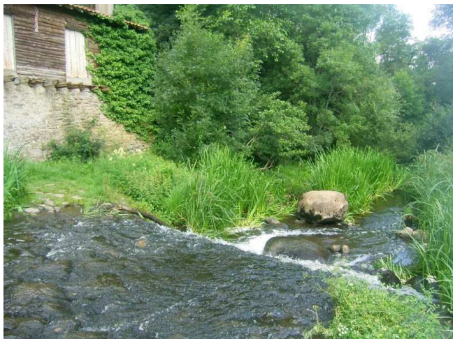
Chaussée de la Tréлитиєre en surverse – Maine Juillet 2012 – SCE
