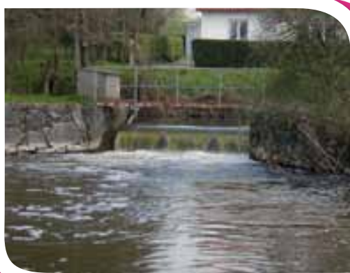
Photographie 69 : ouvrage hydraulique
