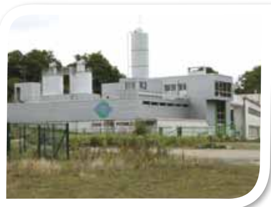
Photographie 17 : usine d'alimentation en eau potable
