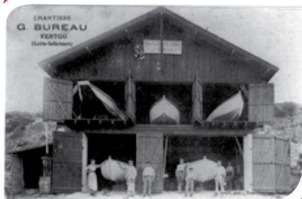
Photographie 25 : chantiers de construction navale
