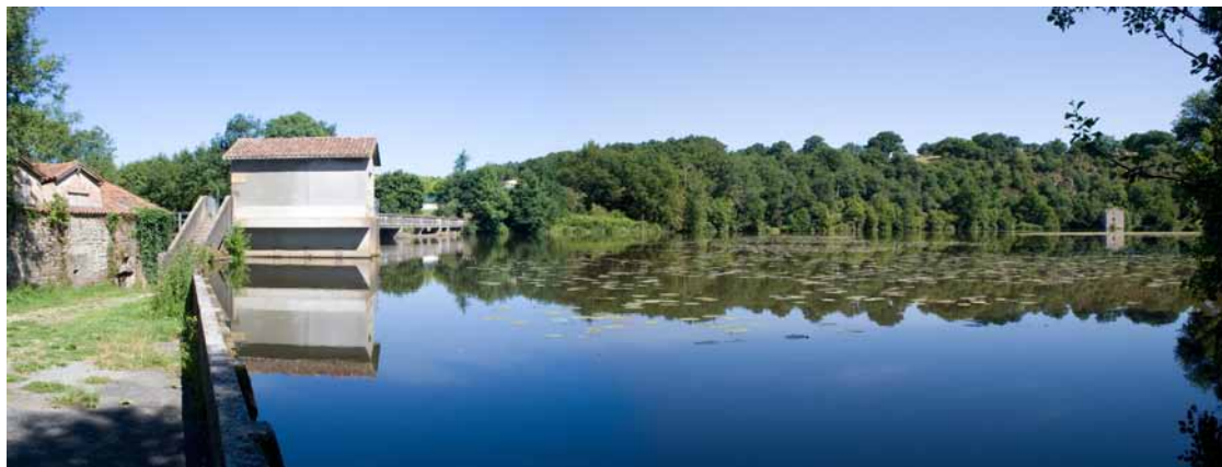
Barrage du Longeron (49) © SR
