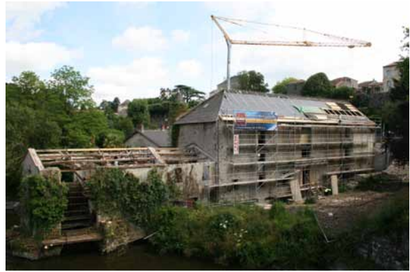
Chantier du moulin de Nid d'Oie à Clisson (44)
