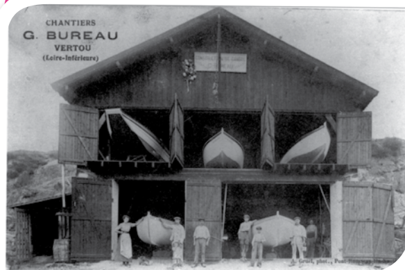
Photographie 25 : chantiers de construction navale
