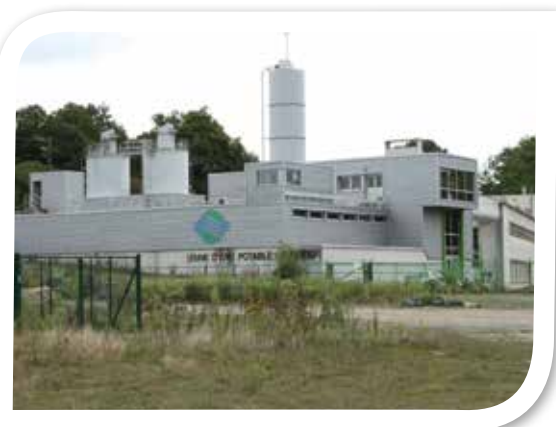
Photographie 17 : usine d'alimentation en eau potable
