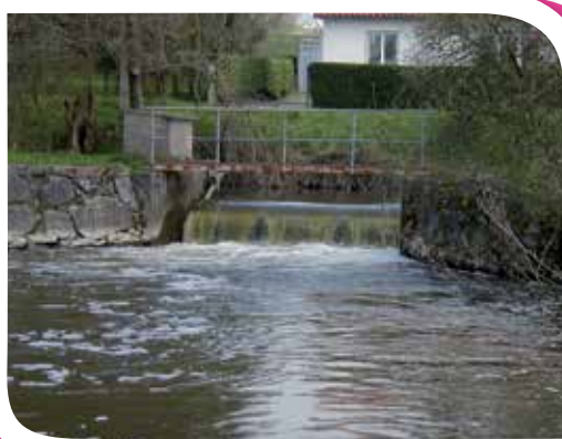
Photographie 69 : ouvrage hydraulique
