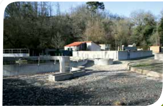
Photographie 21 : station d'épuration
