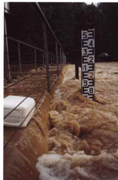
Le Moulin de Bouchot – crue de mai 2000
