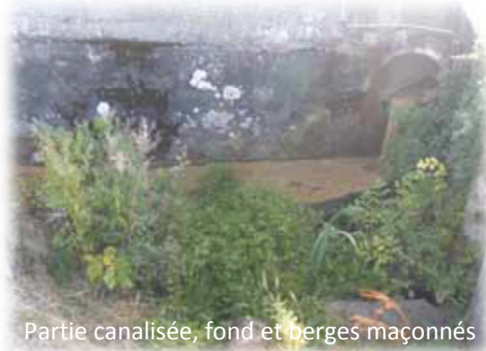
Partie canalisée, fond et berges maçonnés
