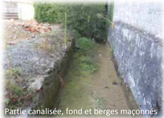
Partie canalisée, fond et berges maçonnés
