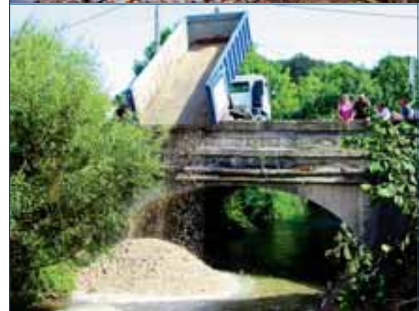
↑ Figure 21 : En haut, exemple de dépôt de matériaux le long de la berge en attente d'une reprise par le cours d'eau l'Azergues (69). En bas, déversement de matériaux dans la Scie (76). ≈
