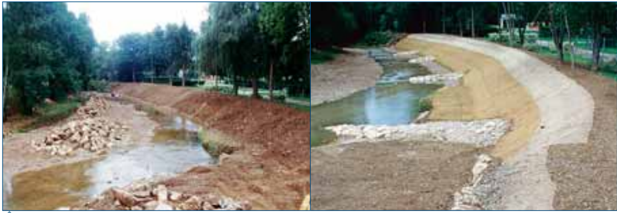
↑ Figure 11 : Travaux de démontage des empierrements existants (30.08.01) puis de réutilisation des blocs dans le cadre de la mise en place d'épis déflecteurs (18.09.01). ≡
