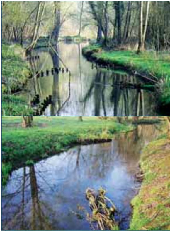
↑ Figure 3 : Exemples de petits épis à vocation de diversification de l'écoulement sous-dimensionnés par rapport à la puissance du cours d'eau. Il n'y a quasiment pas d'effet hydraulique. ≍
