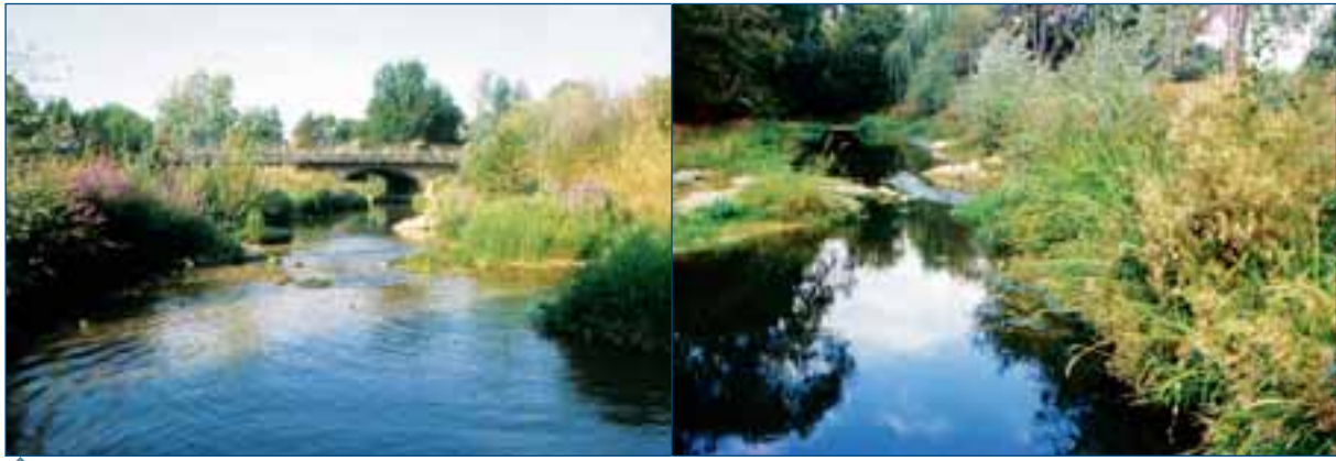
↑ Figure 15 : Trois ans après les travaux, ce tronçon de la Brenne "décorrigé" a retrouvé une certaine diversité écologique ainsi que des faciès d'écoulement variés à l'origine d'une "mosaïque" végétale. ≈
