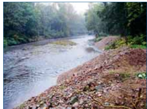
↑ Figure 20 : Exemples de travaux de recharge alluviale sur la Scie (76), avec mise en forme des matériaux apportés. ≈
