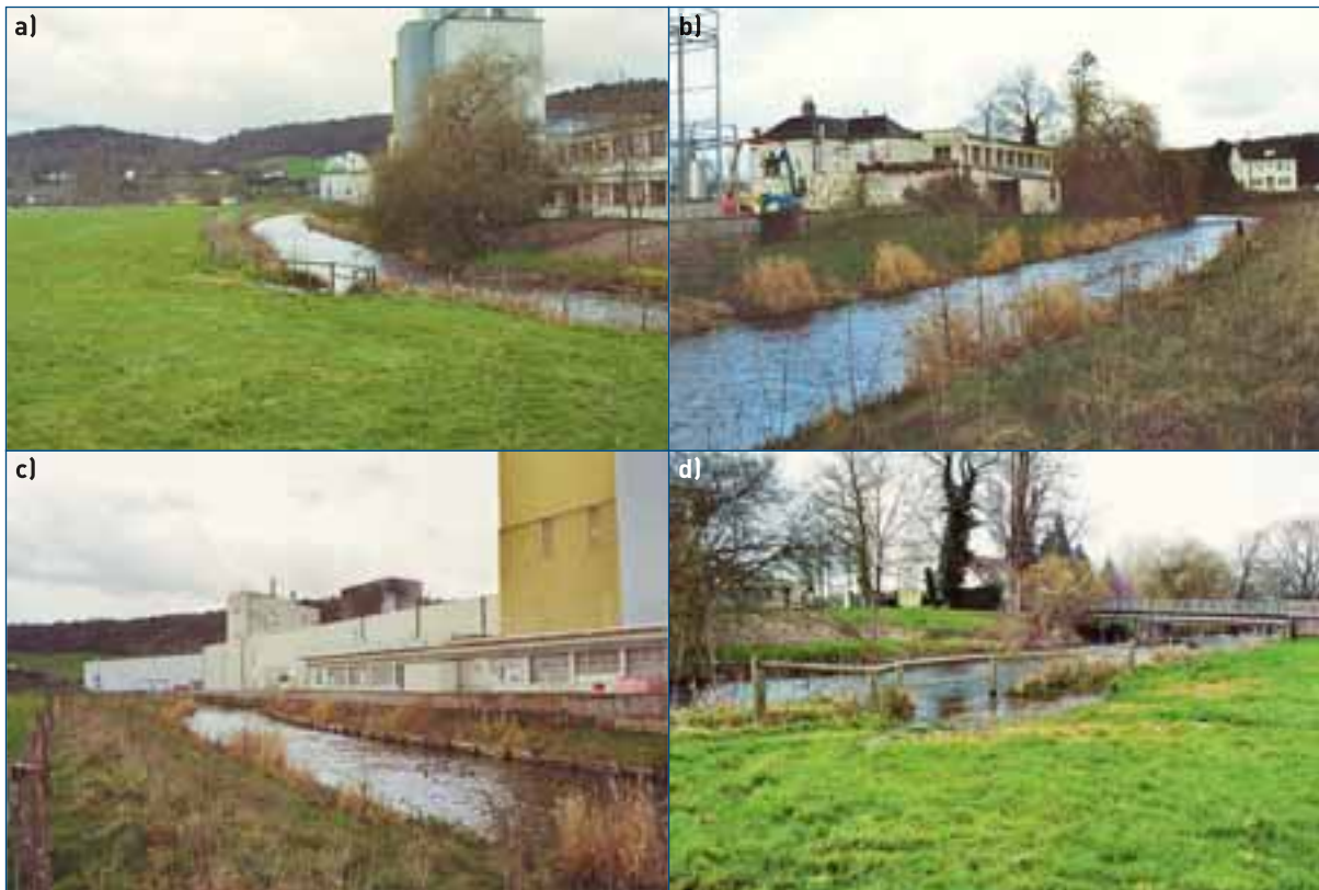
↑ Figure 63 : Vues du site en date du 26.02.07. a) Vue d'ensemble du lit restauré. b) Cordons d'hélophytes bien représentés en berges droite et gauche. c) Protection de berge localisée en début de tronçon restauré. d) Abreuvoir à bétail et clôture provisoire de protection des aménagements. ≡
