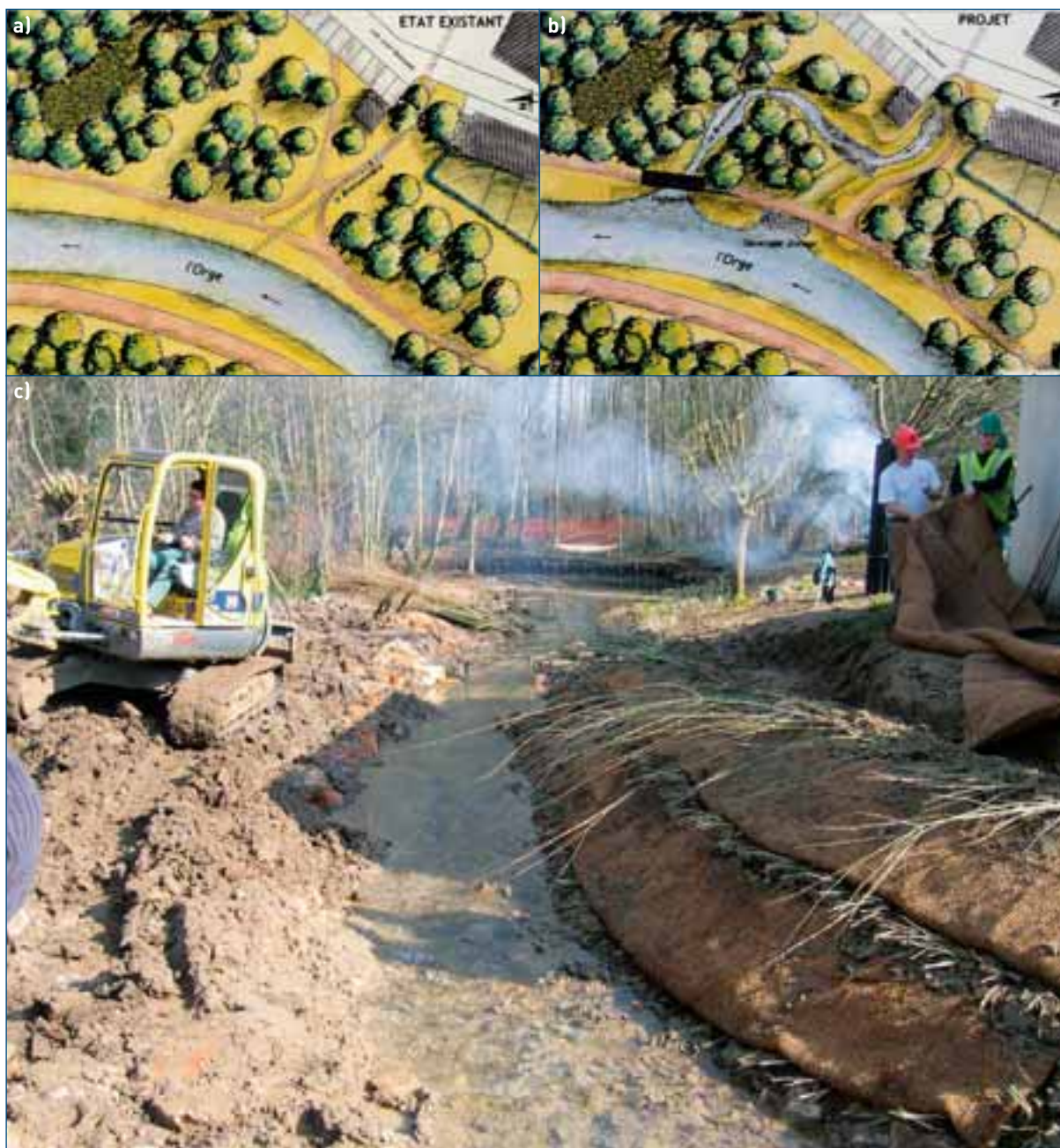
↑ Figure 59 : Vue d'une partie du secteur restauré. a) et b) Schémas d'avant-projet (SIVOA). c) Berges du nouveau chenal excavé en cours de modelage (2007). ≍
