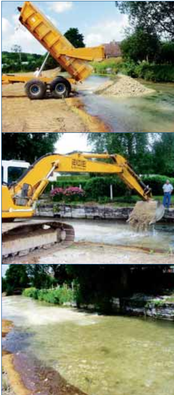
↑ Figure 20 : Exemples de travaux de recharge alluviale sur la Scie (76), avec mise en forme des matériaux apportés. ≈
