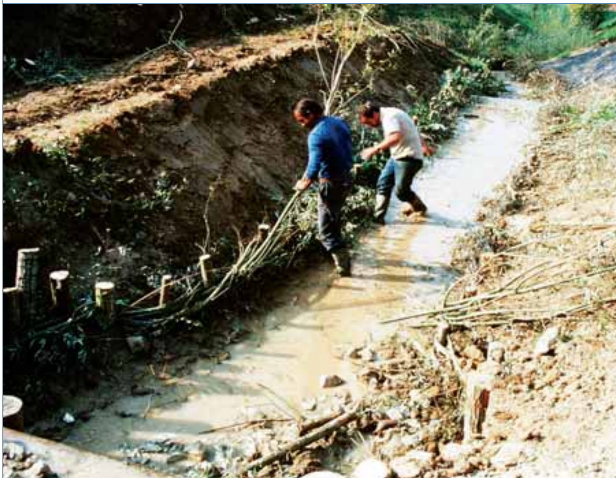
↑ Figure 5 : Illustrations de techniques du génie végétal. Profil type d'un tressage de saules en haut et détail de réalisation en bas. ≍
