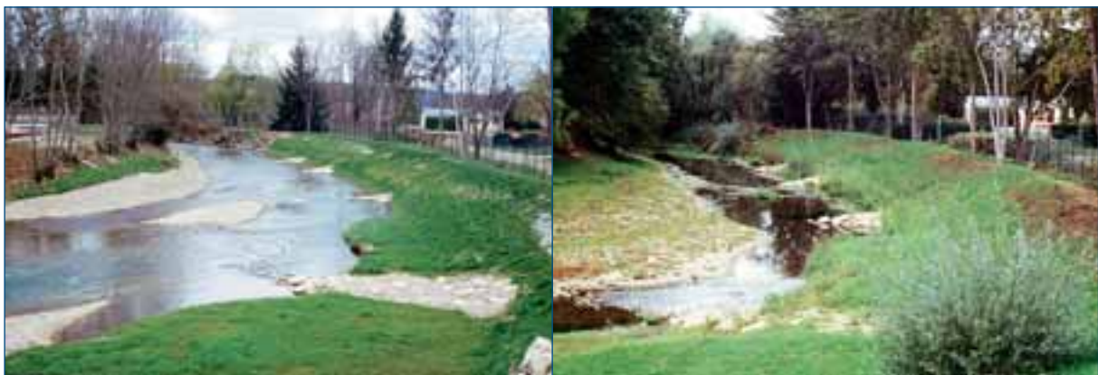
↑ Figure 12 : Début de reprise végétale et formation de premiers atterrissements (14.03.02) puis état des ouvrages en fin de première saison estivale (25.09.02). ≡
