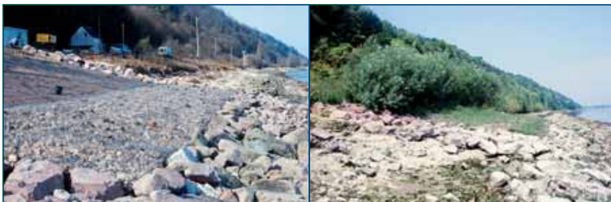
↑ Figure 74 : (13.03.03) Vues d'ensemble de la plage d'essai en fin de travaux à gauche, avec des ancrages de ceinture en enrochement, les matelas-gabions susmentionnés et le haut de berge végétalisé et deux ans après les travaux à droite (27.06.05). Les saules ont connu un développement de 3 à 4 mètres en deux ans. La Seine a apporté quelques dépôts de vase sur les matelas-gabions ainsi que diverses graines de végétaux herbacés, ce qui fait que deux ans à suivre des travaux, bien que non végétalisés lors du chantier, les matelas-gabions sont colonisés par un développement spontané et indigène d'hélophytes. Aucune érosion n'est constatée mais un léger tassement de la partie basse en matelas-gabions. Ces derniers ont précisément été prévus pour « absorber » de façon souple d'éventuels tassements ou enfoncements des enrochements sous-fluviaux maintenus. ≡
