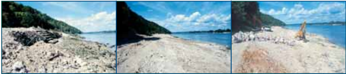
↑ Figure 71 : (12.09.01) Les restes des anciens gabions sont démolis, l'ensemble de la berge est terrassé en pente douce, les blocs de la protection sous-fluviale et de pied de berge sont acheminés sur le site. Les terrassements se déroulent de l'amont à l'aval. ≡
