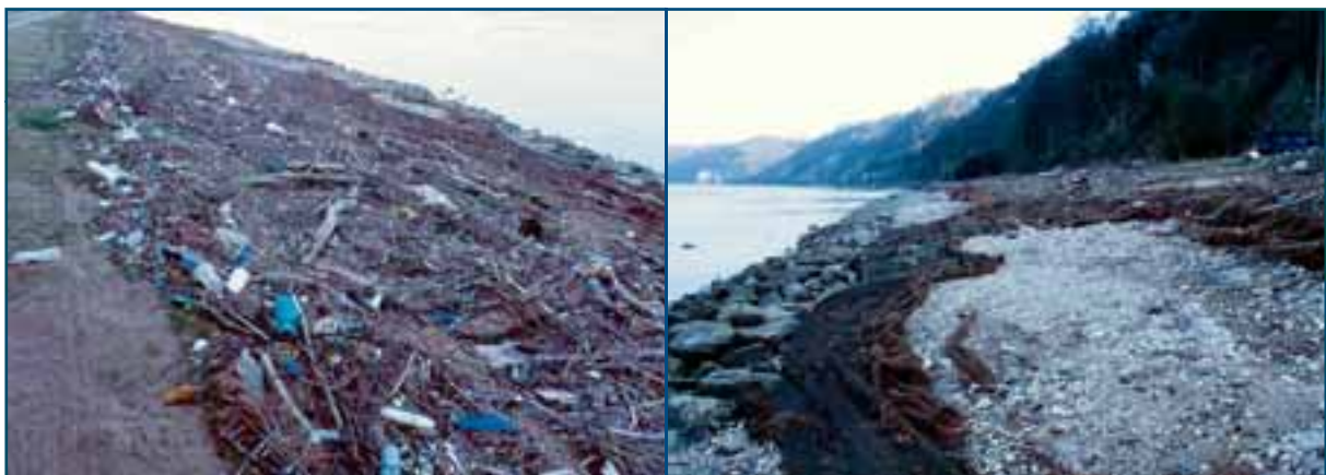
↑ Figure 73 : (27.03.02) Evolution de la berge aménagée 4 mois après les travaux, avec à gauche de nombreux déchets et pas que « végétaux » qui sont apportés par la marée. A droite : par endroits, les végétaux ont déjà totalement disparu avec les géotextiles qui sont déchirés. ≡
