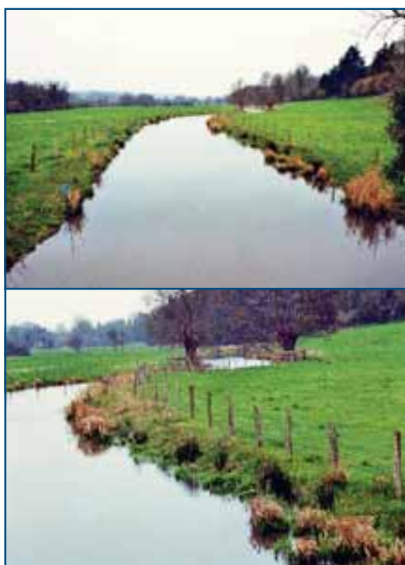
↑ Figure 83 : (27.02.07) Vues des travaux d'arasement de merlons réalisés en 2005 à St-Aubin-sur-Scie. ≈
