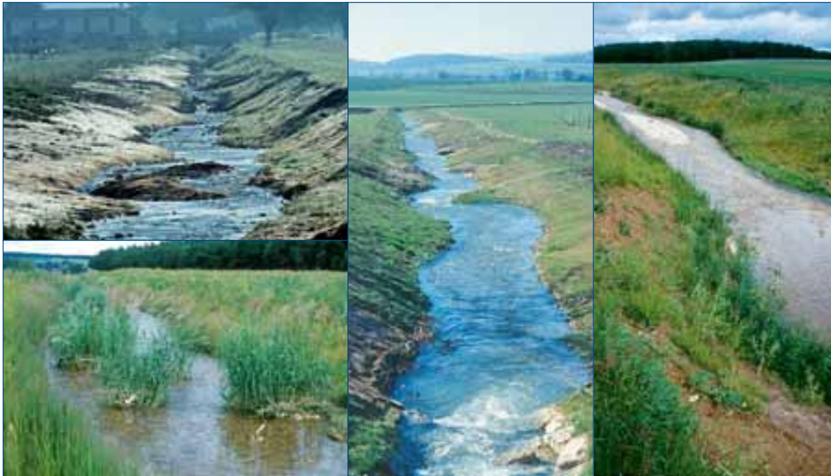
Figure 60 : Sur un tronçon de cours d'eau restauré, exemple d'alternance de radiers, de mouilles, de risbermes, de berges à pente douce et à profil plus abrupt, de bancs de graviers, d'îlots centraux, etc., avec une emprise limitée ici à 12 mètres pour un cours d'eau anciennement chenalisé sur une largeur de 5-6 mètres. ≡
