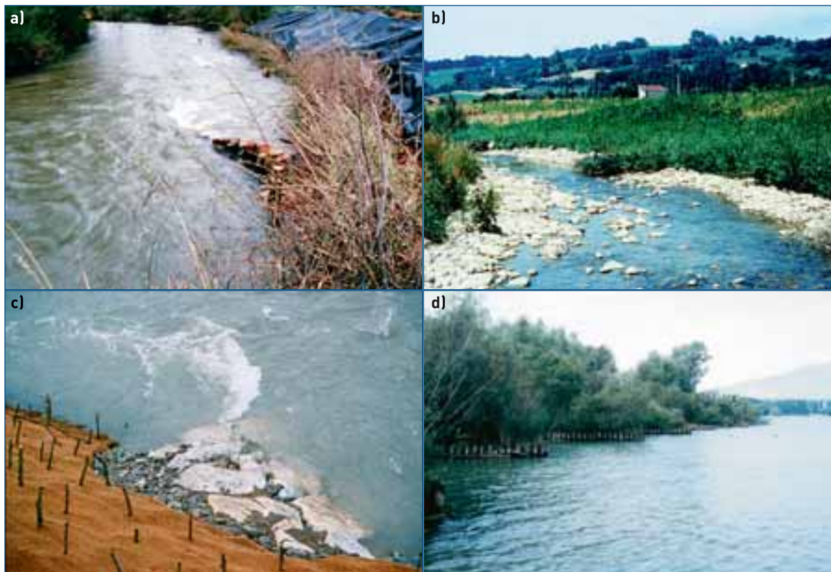
↑ Figure 7 : Exemples de différents types d'épis. a) Epi plongeant en pieux. b) Epi en fascine de saule. c) Epi plongeant en blocs d'enrochement. d) Epis végétaux pour favoriser le développement de roselières. 🌊
