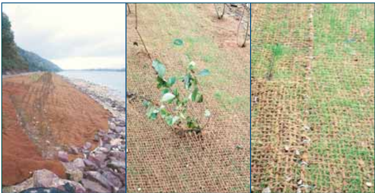
↑ Figure 72 : (07.11.01) Jour de la réception des travaux. Vue d'ensemble de la berge réaménagée avec en premier plan la transition amont (berge raide/berge en pente douce), les plantations d'arbustes en haut de berge et le début de reprise des ensemencements à travers les géotextiles. ≡
