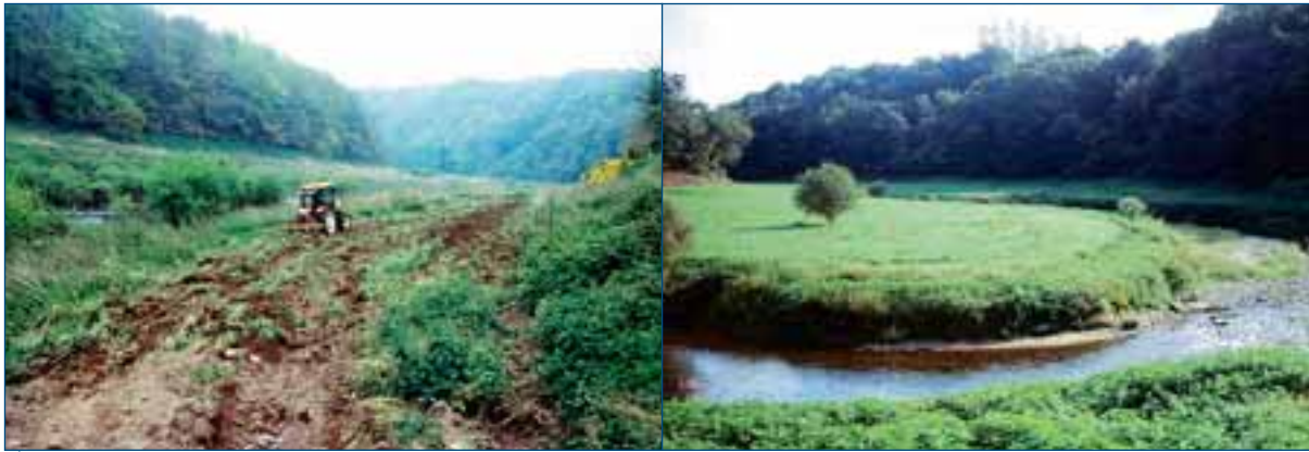
↑ Figure 43 : Vue des travaux de labour en cours dans l'emprise de l'ancienne retenue sur la photo de gauche (09.05.2001) puis des prairies riveraines fraîchement reconstituées en bordure du Léguer à droite (07.09.2001). Conception des aménagements de l'ancienne retenue et photos Biotec. ≈
