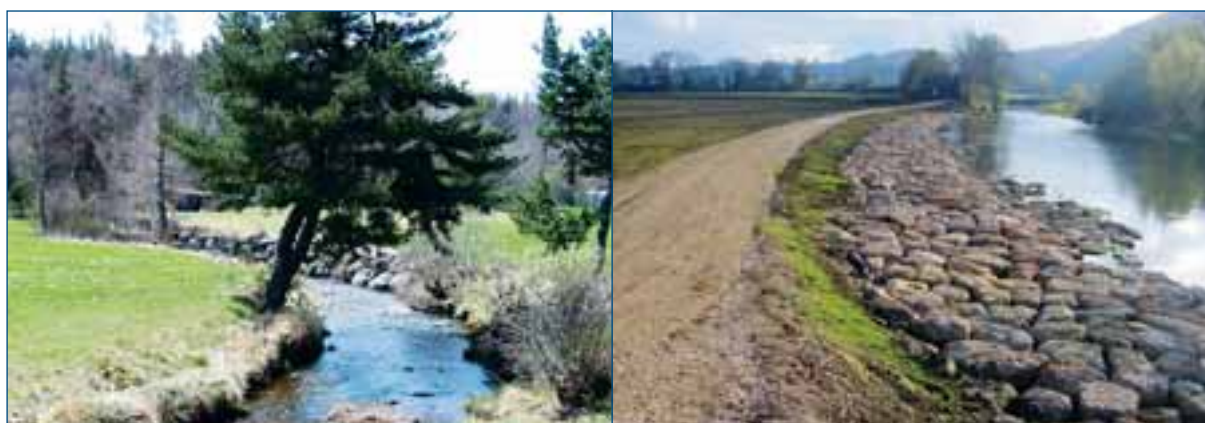
↑ Figure 48 : Exemples de protections de berges en zone rurale sans enjeu majeur. 🌊
