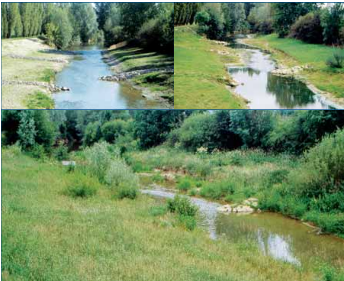
↑ Figure 14 : Travaux visant à favoriser la reconstitution d'un lit d'étiage ou chenal préférentiel d'écoulement de configuration variée et adaptée à la nature des débits existants (travaux au moyen d'épis en blocs et opérations simples de végétalisation – ensemencements, mottes de plantes hélophytes et boutures de saules) – Evolution des aménagements à travers quatre années. ≡
