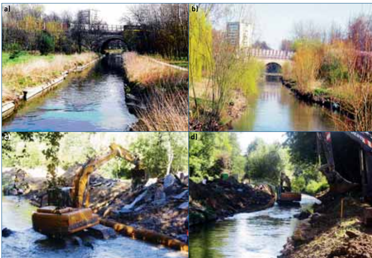
↑ Figure 54 : Vue d'une partie du secteur restauré. a) Avant les travaux (photo Biotec). b) En 2007. c) et d) Suppression des protections en béton (photos SIVOA). ≈
