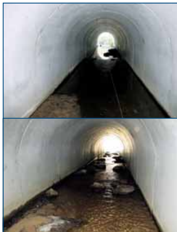
↑ Figure 103 : Exemple d'un « tunnel » de franchissement avant travaux de diversification du lit en haut et après « réaménagement » en bas. ≍
