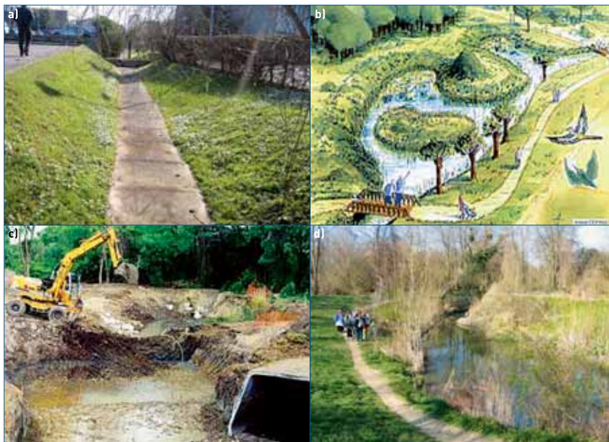
↑ Figure 57 : Vues du secteur restauré. a) Amont du secteur restauré. b) Esquisse du projet. c) Travaux de réouverture (2003) [noter la présence d'une partie du collecteur à droite] [source b) et c) : atelier Cepage]. d) Secteur restauré (2007) [source a) et d) : Malavoil].
