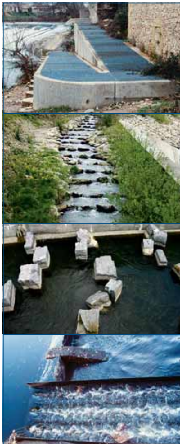
↑ Figure 100 : Différents types de passes à poissons. 🌊
