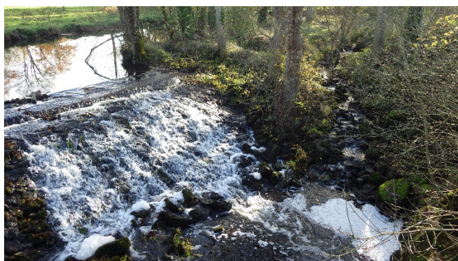
Chaussée de Bois Chaudeau
