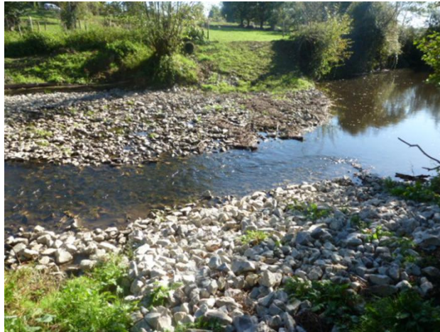
Restauration d'un passage à gué sur la Petite Maine à Saint-Georges-de-Montaigu
