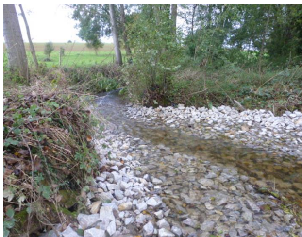
Arasement du seuil de la Burnière
