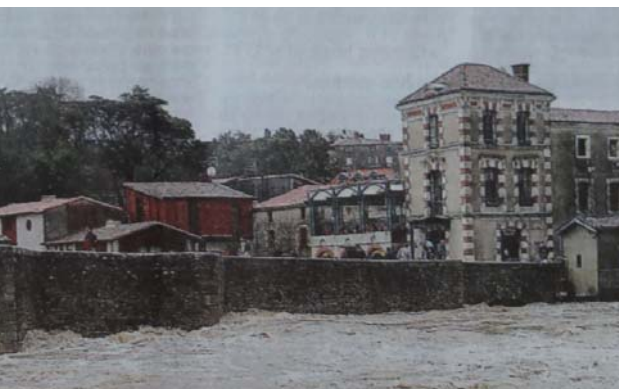
Le pont de la Vallée, au pied du château de Clisson, lors de la crue d'avril 2003. Source : EPTB.
