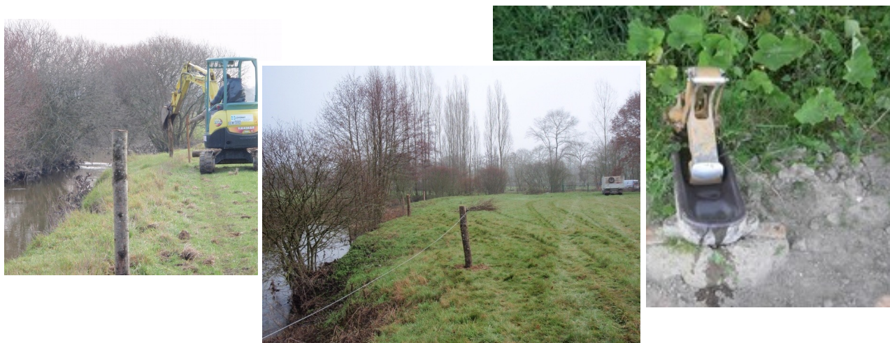
Illustration 4 - Pose de clôtures et installation d'abreuvoir
