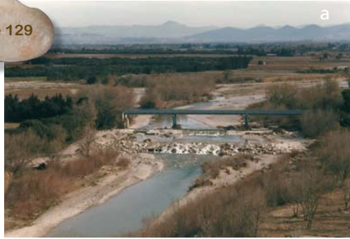
(a) seuils de stabilisation en aval d'un pont. (b) seuil de stabilisation en section courante.
