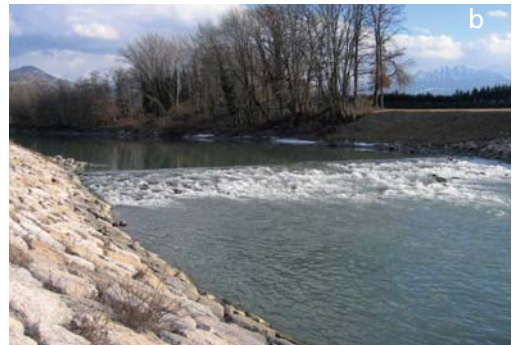
(a) seuils de stabilisation en aval d'un pont. (b) seuil de stabilisation en section courante.
