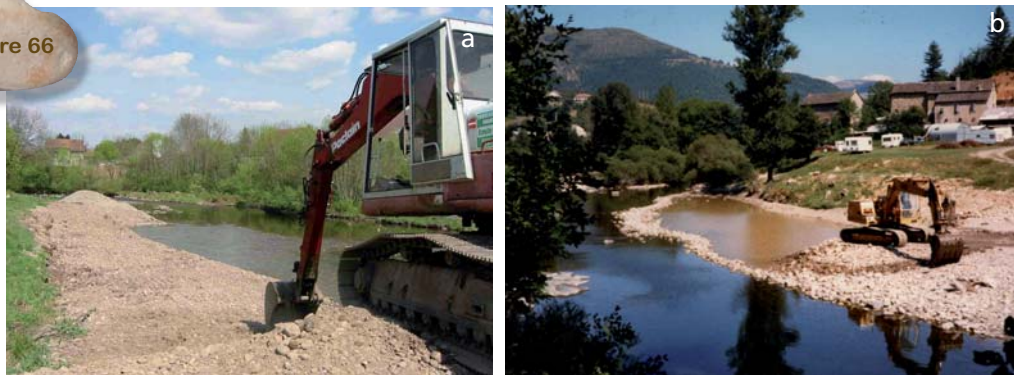
(a) curage d'entretien sur l'Ognon, (b) extraction commerciale sur le Tarn dans les années 80. La différence n'est pas flagrante...
