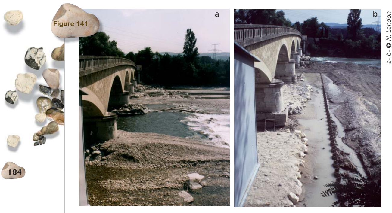
a) travaux d'urgence (1995) suivis des travaux de reconstruction (b) du seuil du pont d'Allex-Grâne sur la Drôme.
