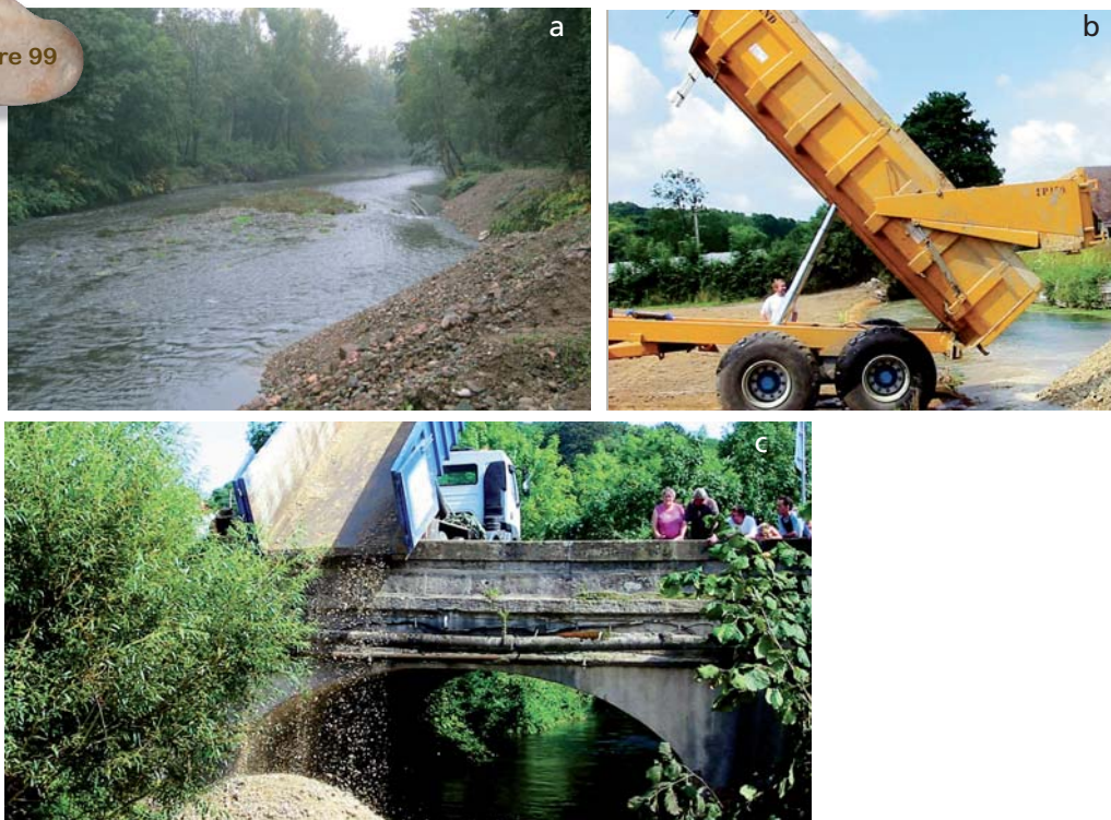
(a) dépôt des matériaux curés le long d'une berge en aval du site à enjeux, afin de favoriser leur reprise par l'écoulement à la prochaine crue, (b) et (c) méthodes plus expéditives.
