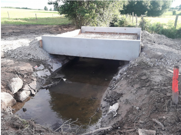
Aménagement d'un pont passerelle en lieu et place d'un passage busé sur le ruisseau du Grand Ry / Les Herbiers
