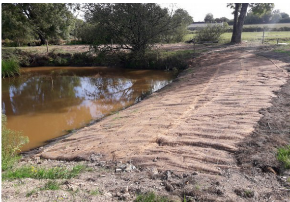
Consolidation de la digue de Moulin Neuf (août 2020)
