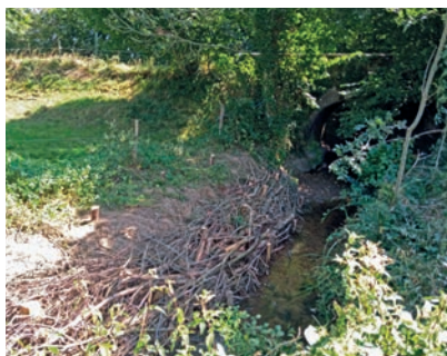
Peigne en cours de construction sur une des berges de l'Ouin - 08/ 2021
