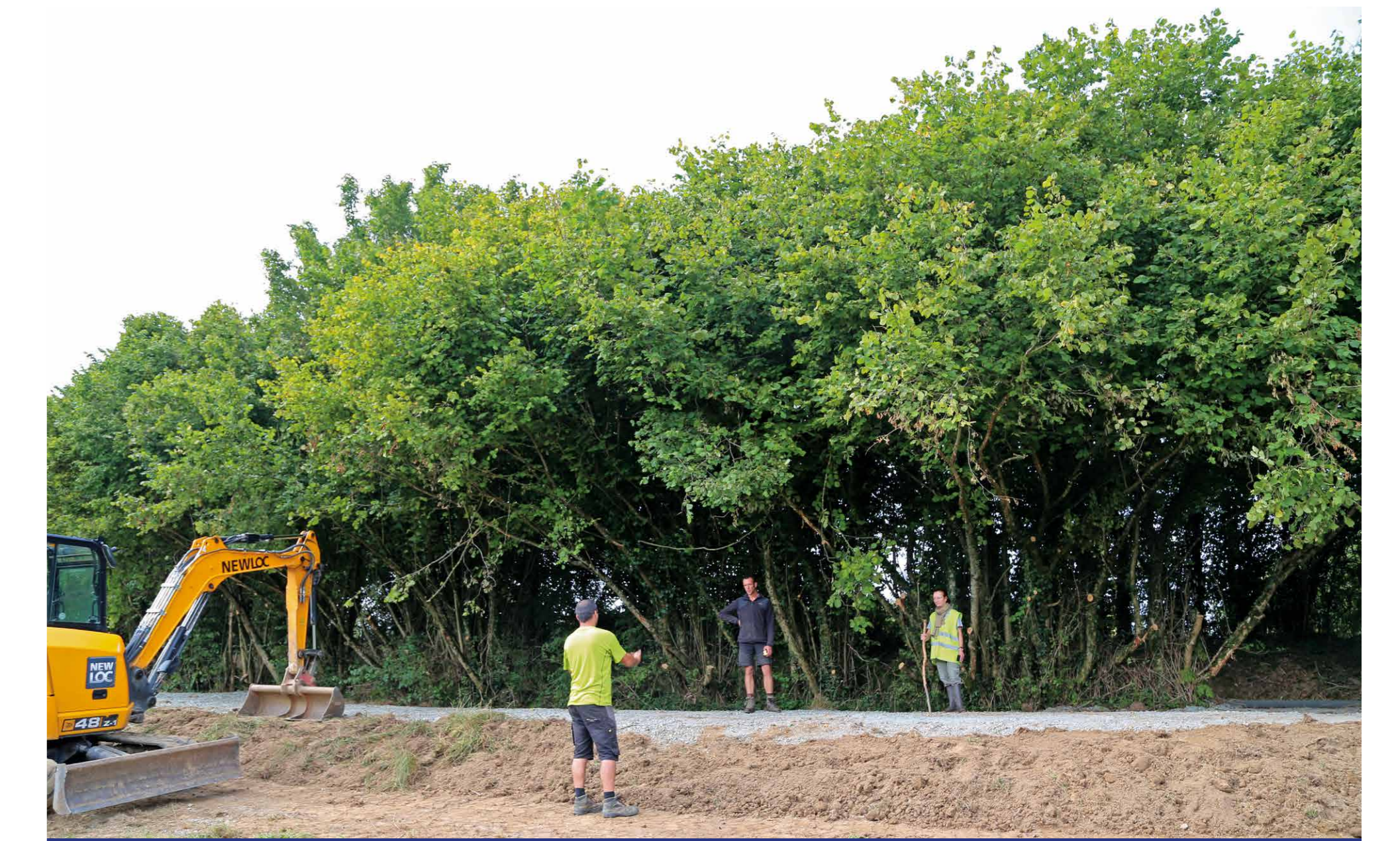
Travaux de mise en oeuvre de la plateforme d'accueil
