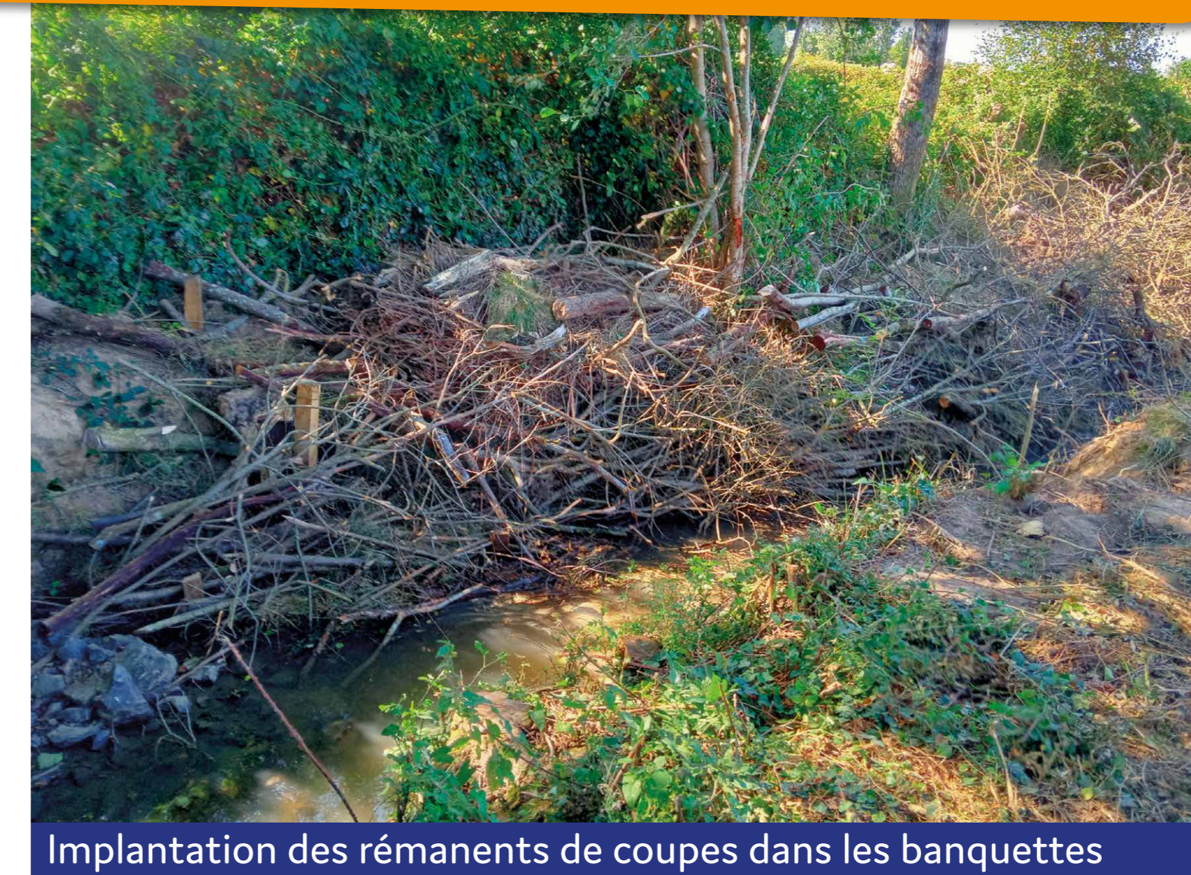
Implantation des rémanents de coupes dans les banquettes
