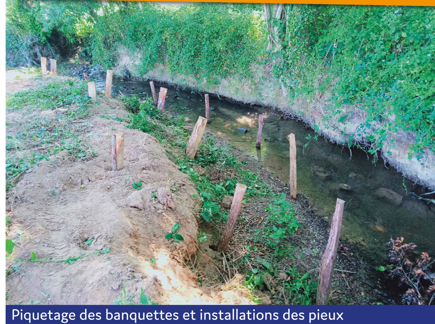
Piquetage des banquettes et installations des pieux
