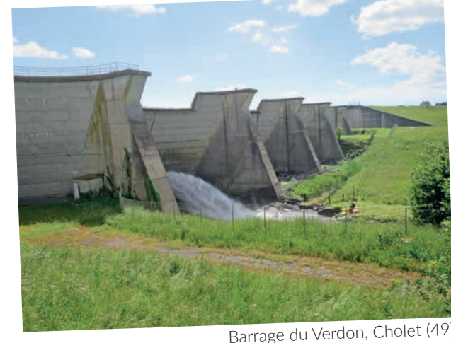
Barrage du Verdon, Cholet (49)
