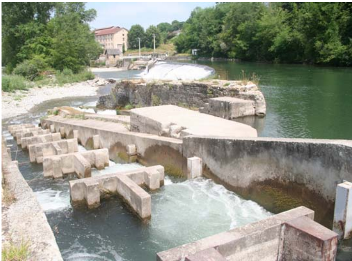
A droite : Echelle à poissons de la microcentrale à Navarrenx (64), sur la rivière Gave d'Oloron Juillet 2006 Crédit photo : Bernard Rousseau
