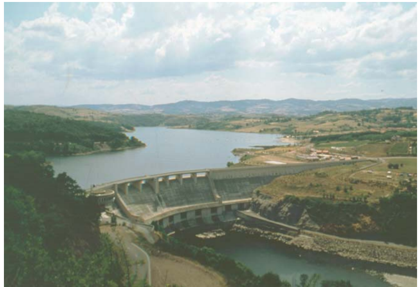
Barrage de Villerest (42), mai 2001 Crédit photo : Agence de l'eau Loire Bretagne
