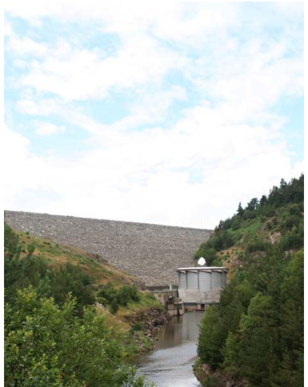
Barrage de Naussac à l'aval, 2006 Crédit photo : Bernard Rousseau
