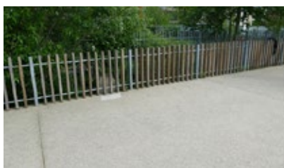
Sol en granulats liés à la résine, école primaire Stéphane Hessel, Montreuil © CAUE de Paris
