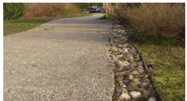
Tranchée drainante © Grand Lyon
