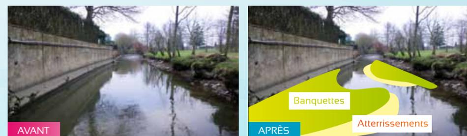
> Dans le secteur de la Mignauderie et de Saint Jouin l'écoulement sera resserré par la création de banquettes végétalisées, afin d'augmenter la hauteur d'eau, de faciliter la circulation des poissons et de dynamiser les écoulements.
