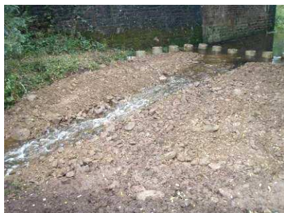
Aval Pont de la Galussière après travaux
