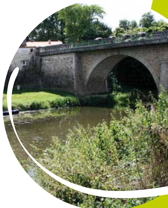
Pont de Monnières
