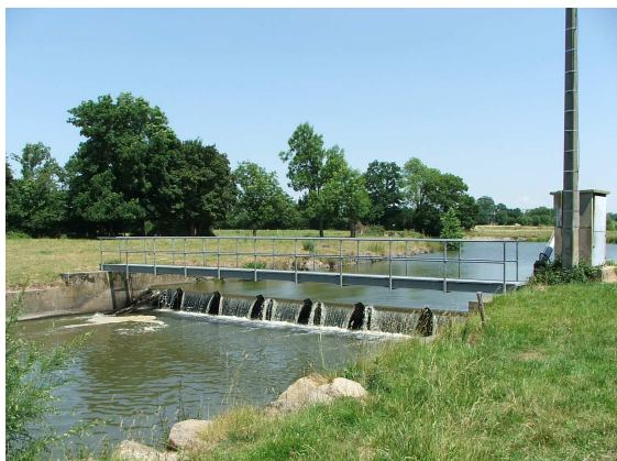
Clapet de la Naulière avant abaissement
