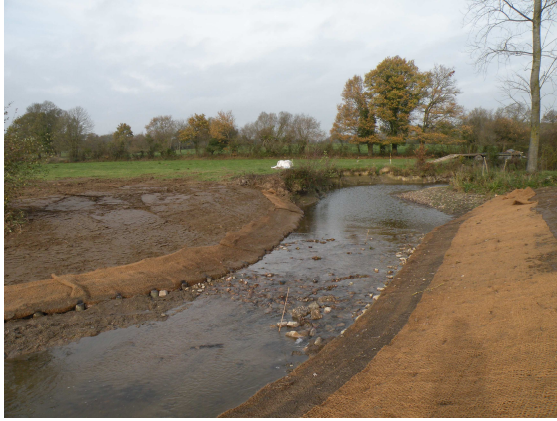
Banquettes bilatérales végétalisées et radier central
