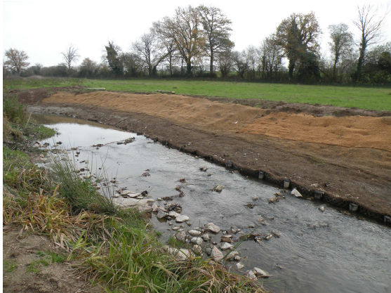
Radier, banquette végétalisée en rive gauche et retalutage de berge en rive droite.
