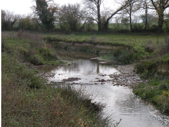
Ennoisement d'un ancien gué bétonné par création d'un radier en aval
