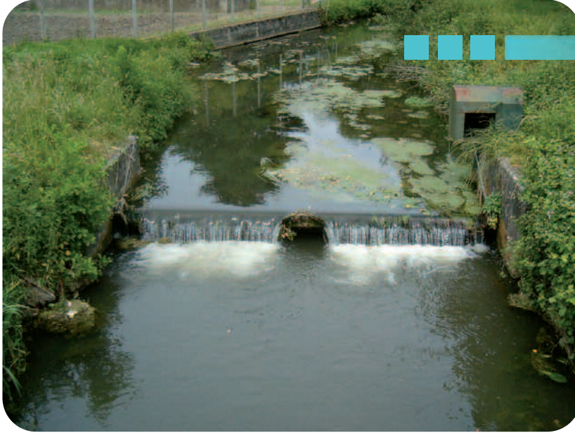
Prolifération d'une végétation aquatique liée aux eaux stagnantes sur une retenue du Couasnon (Maine et Loire)
