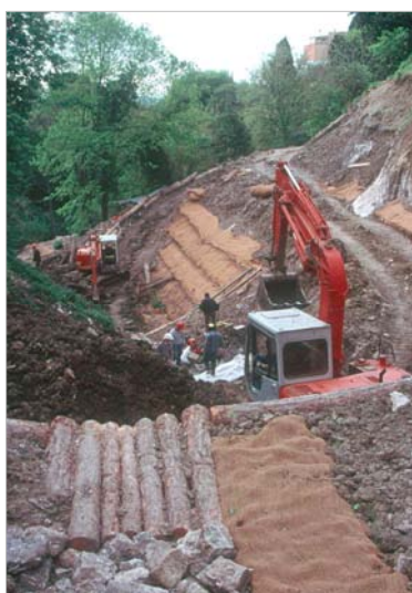
Figure 19 : Pour consolider certains talus du vallon risquant de bouger avec l'eau, des lits de plants et plançons ont été confectionnés, doublés avec des géotextiles biodégradables. On notera la pente très raide des talus traités, malgré tout, en techniques végétales pures (14.04.99)
