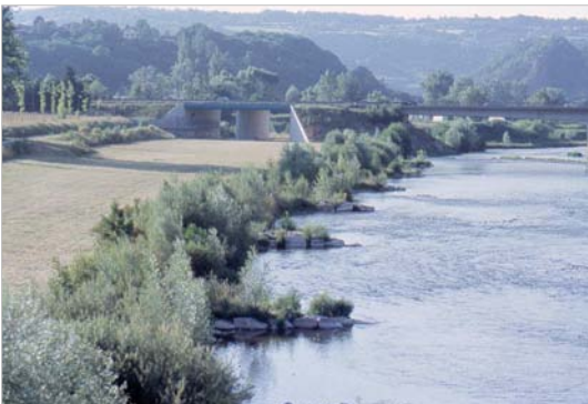
Figure 31 : Vue du même site quatre ans après les travaux. Les épis en déflecteurs (recentrage du courant) évitent à des dépôts d'alluvions de se créer trop près des berges, ce qui aurait pour effet d'augmenter les contraintes de cisaillement du courant contre la berge (juillet 2002)
