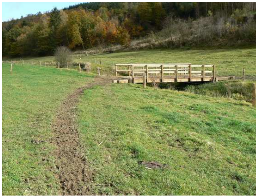
Figure 4 : Construction d'une passerelle en bois au dessus d'un ruisseau pour le passage du bétail. Quelques semaines après la fin du chantier, les traces au sol indiquent que le ponton est utilisé régulièrement
