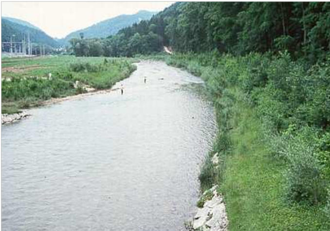
Figure 26 : Développement de la végétation. La berge droite a été plantée d'espèces indigènes devant jouer un rôle paysager de cicatrisation de la forêt, tout en stabilisant la berge. La rive gauche a été traitée avec des techniques végétales simples (herbacées) et deux petits massifs de buissons aux endroits critiques. La pente des berges a été variée pour diversifier la morphologie et laisser s'installer une dynamique de colonisation végétale (1988)
