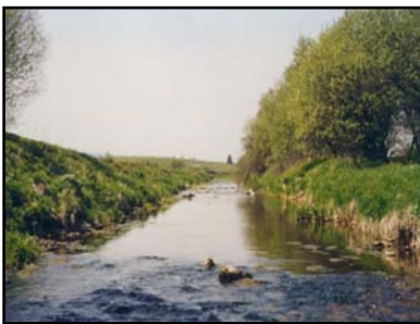
Figure 4 : Renaturation du Haut-Dugeon : de gauche à droite, le chenal rectiligne et incisé en 1996 ; vue aérienne des travaux ; lit restauré méandriforme et connecté à sa zone humide en 2000, 3 ans après les travaux
