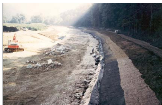
Figure 25 : Les terrassements du nouveau tracé sont terminés. La protection contre l'érosion s'est faite avant tout avec la mise en place de différents géotextiles et des espèces herbacées (septembre 1984)
