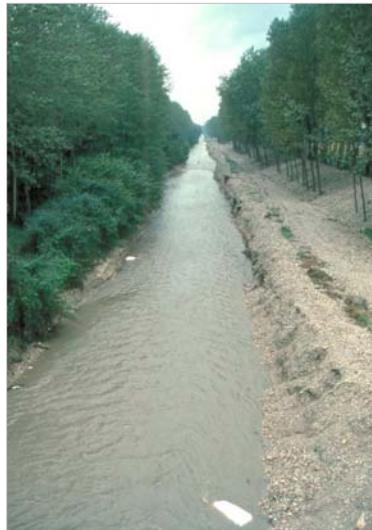
Figure 4 : Chenalisation brute d'un cours d'eau. La destruction de la végétation typique des berges permet la croissance d'espèces invasives comme la renouée du Japon.
