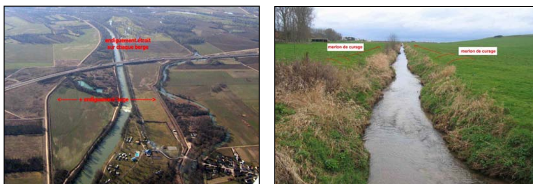
Figure 11 : A gauche : vue aérienne d'un système à double endiguement en zone rurale (protection des cultures). Etroit pour les crues fréquentes et large pour les crues plus rares. A droite, vue de merlons de curage se traduisant par un véritable endiguement (photos Malavoi)
