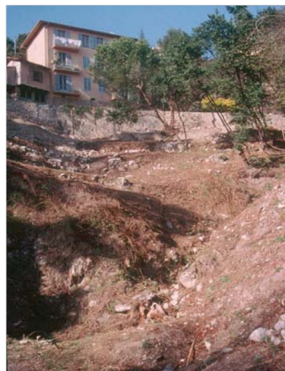
Figure 15 : Débroussaillage et nettoyage du site avant travaux. On distingue une incision importante du lit (17.02.99)
