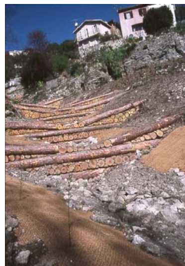
Figure 18 : Vue côté amont des barrages-bois en fin de chantier. Le lit a été relevé et les rives sont mieux stabilisées de même que les murs liés aux maisons (mars 1999)
