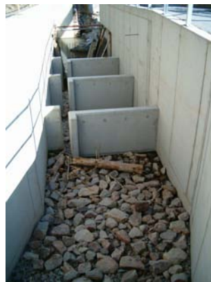
Figure 9 : Vue des bassins à sec de la nouvelle échelle à poissons de Lorcé sur l'Amblève. Les bassins sont équipés d'un substrat de fond pour permettre le passage des petites espèces benthiques de poisson (chabot, petite lamproie) et des macroinvertébrés
