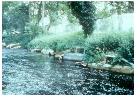
Figure 7 : Style particulier de protection contre l'érosion (carcasses de voitures).
