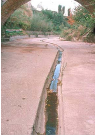
Figure 2 : Exemple où le lit a été complètement bétonné mais où l'on a gardé un certain méandrage !
