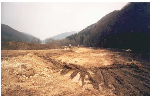
Figure 24 : Diverses raisons liées à la sécurité routière et face aux inondations ont nécessité le déplacement de ce cours d'eau dont on voit ici les premiers terrassements (mars 1984)
