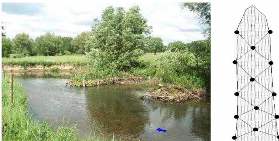
Figure 1 : Epis sur la Berwinne au lieu-dit La Folie, vue vers l'aval en étiage et schéma de conception
