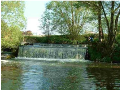
Figure 5 : Obstacle infranchissable à la libre circulation des poissons présents à Thy-le-Château
