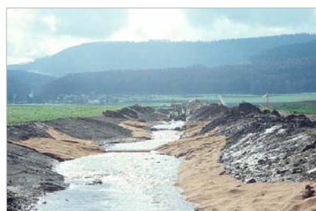
Figure 36 : Etat à la fin des terrassements avec la création de berges en pente douce et variées, ainsi que la création d'îlots. Sur les petits cours d'eau, on peut travailler dans cet espace restreint avec tout de même de bons résultats (27/09/01)
