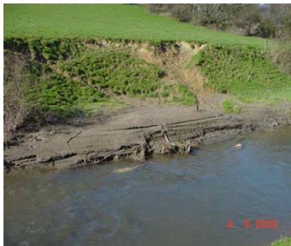
Situation avant travaux mars 2002
