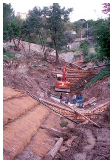
Figure 20 : Vue d'ensemble du chantier montrant le mode opératoire et les processus de construction avec les machines (14.04.99)
