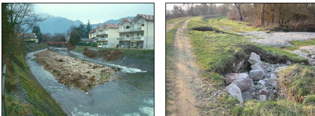
Figure 10 : A gauche, endiguement en béton sur les deux berges en zone urbanisée (photo Biotec). à droite digue en enrochements + remblai (sapé par déversement) en zone rurale (la rivière est à gauche) (photo Malavoi)
