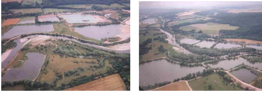
Figure 16 : Exemples d'extractions en lit majeur. On observe que le lit mineur a souvent été rectifié et endigué (photos Malavoi).
