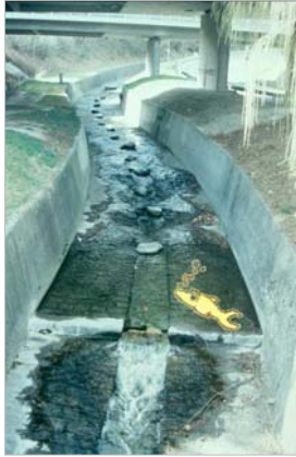
Figure 5 : Lit en béton et en pierre dans lequel des blocs de pierres ont été placés pour permettre la circulation des poissons (!)
