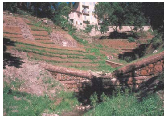
Figure 21 : Les techniques végétales commencent à produire leurs effets quelques semaines après la fin des travaux (23.06.99).
