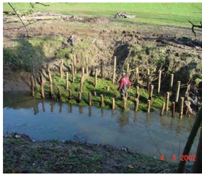
Travaux en mars 2002
