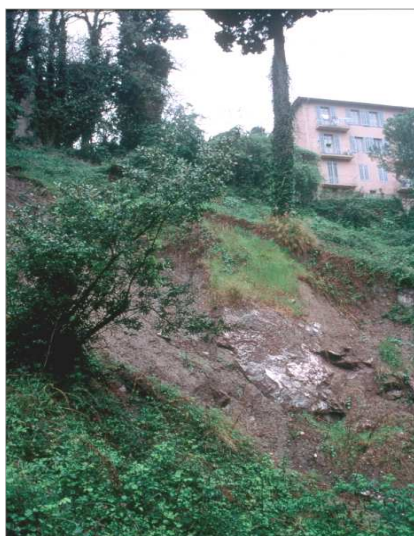
Figure 14 : Vue d'un glissement avant les travaux, avec affleurements de gypse (printemps 1998)
