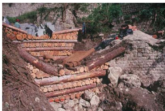
Figure 17 : Les barrages en bois ont été construits. Dans la mesure du possible, ils s'encastrent dans et entre des murs existants de manière à consolider les talus et relever le lit au maximum (24.03.99)
