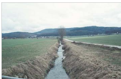
Figure 35 : Etat de la Cornoline, avant travaux, avec pied de berge et seuils en béton, tracé rectiligne et végétation très peu diversifiée (14/02/00)
