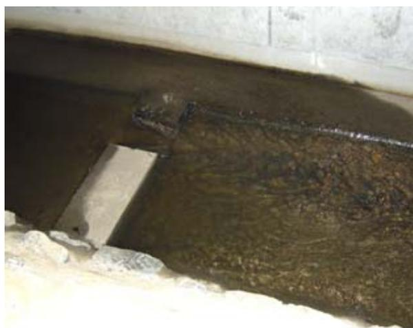
Photographies 7, 8, 9 et 10 : exemples de seuils (ou déflecteurs ou barrettes) mis en place au sein d'ouvrages fermés afin de dissiper l'énergie hydraulique, rehausser la ligne d'eau, concentrer les faibles débits et stabiliser le substrat en place : photographies avant et après la mise en eau de l'ouvrage (sources : DREAL Midi-Pyrénées, CETE de l'Est).
