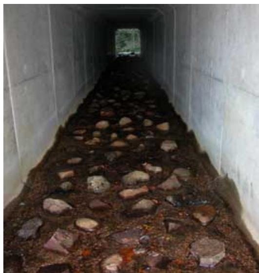
*Nota* : en présence de l'anguille, la mise en place d'un substrat rugueux est recommandée « par défaut » dans tout ouvrage hydraulique, cette espèce se déplaçant par reptation.
