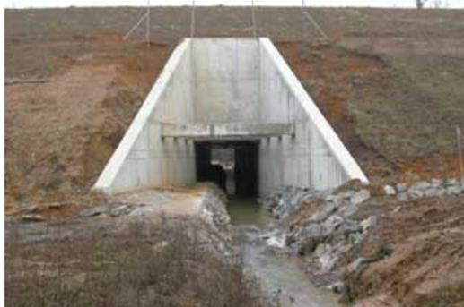
Photographie 16 : Murs en aile et « butons » pour réduire la longueur de couverture : diminution de longueur de couverture de 30 m (65 m au lieu des 95 m initiaux, surcoût de 6,3%).
