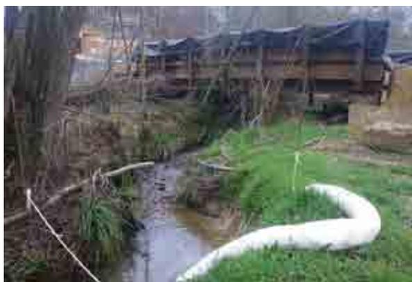
Photographie 6 : exemple de pont provisoire mis en place en phase chantier, préservant le lit mineur et les berges du cours d'eau (source : Onema, Délégation Interrégionale Sud Ouest).
