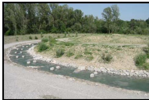
Figure 15 : rivière de contournement seuil de Livron sur Drôme (MRM)
