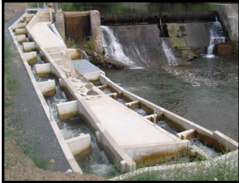
Figure 13 : passe à bassins successifs (barrage la Forge sur l'Aude) (source MRM)
