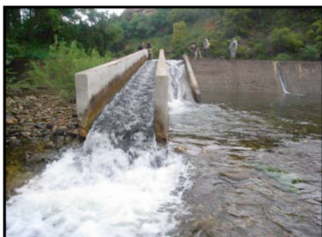
Figure 16 : passe à ralentisseurs du seuil de la Voulte sur le Jaur (MRM)
