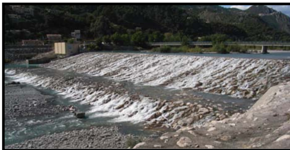
Figures 67 et 68 : seuils de la microcentrale 16 (67) et de la microcentrale 8 (68) sur le Var (MRM)
