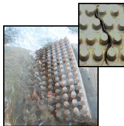
Figure 18 : dalles à plots bétons (MRM)
