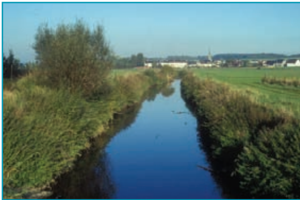
Réalignement de l'Alzette au Roeserbann. Le lit est rectiligne et profond avec des berges colonisées par une flore peu diversifiée (orties, etc.).
