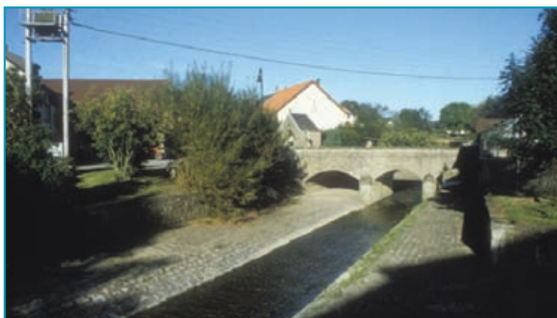
Boudlerbach à Biber : chenal de drainage en milieu urbain.
