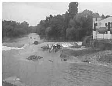
suppression du vannage, rampe d'accès et digues sous l'eau
