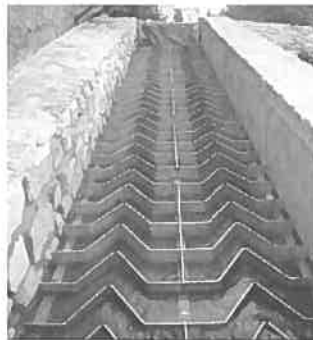
passé à poissons à ralentisseurs de fond suractifs
