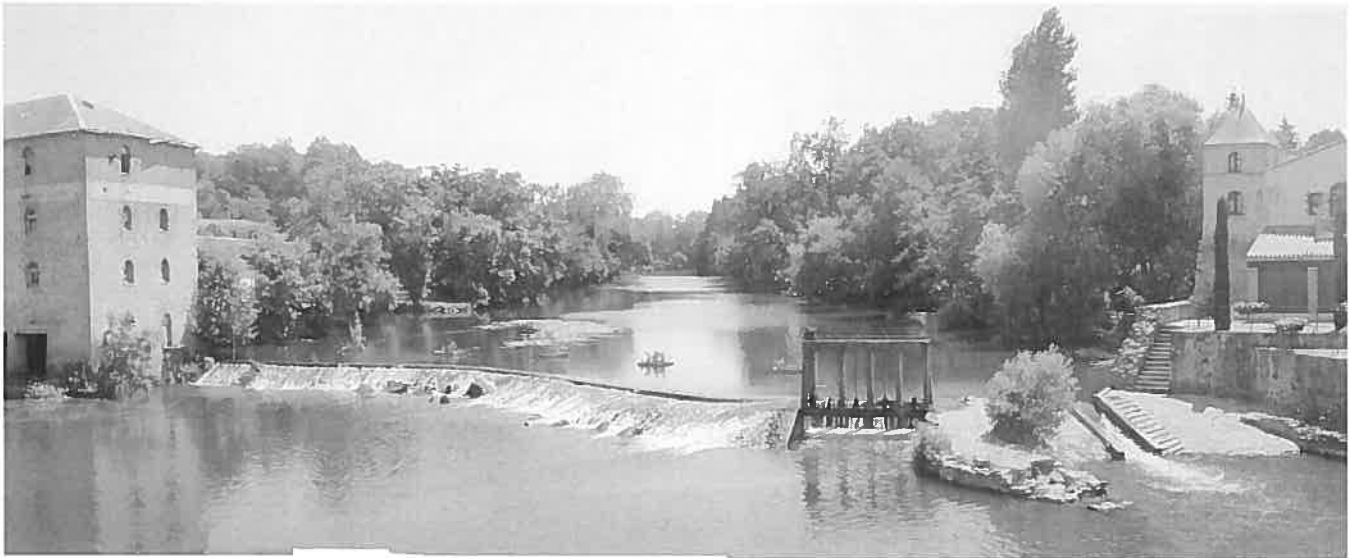
Chaussée du Pont de la Ville avant restauration
