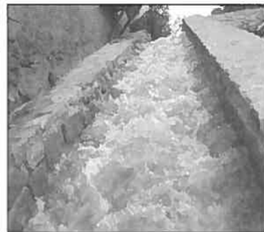
passé à poissons à ralentisseurs de fond suractifs
