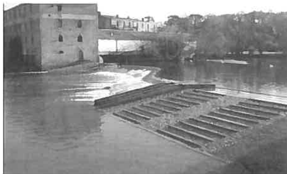
Passé à canoë-kayak et rampe de remontée
