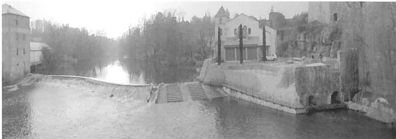
Chaussée du Pont de la ville après restauration, fin de chantier décembre 2007
