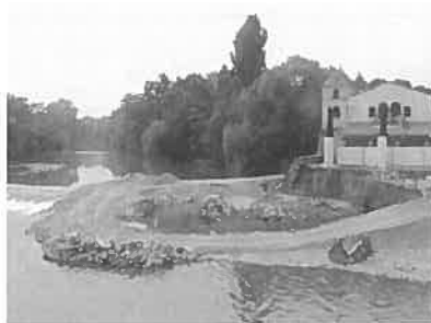
suppression du vannage, rampe d'accès et digues sous l'eau
