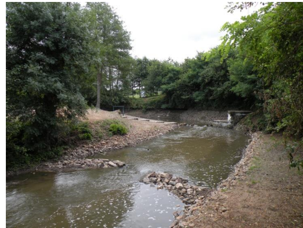
Effacement de l'ouvrage du Carteron (SIAM)
