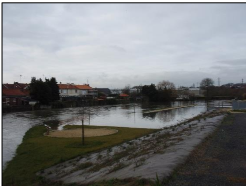
Restauration champs d'expansion de crue
