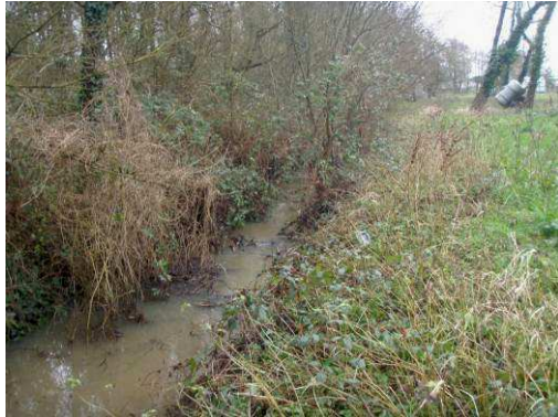
La Brebionnière avant travaux
