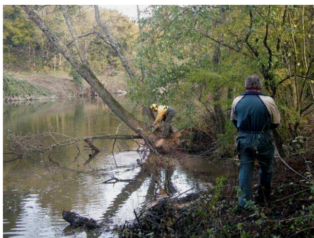
Interventions sur la Sèvre (novembre 2013)
