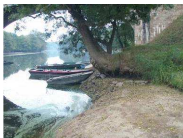
Frêne dans perré du pont (26/09/2013)
