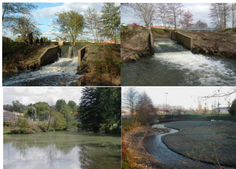
Figure 33 : Evolution du site après l'abaissement du clapet de la Motte sur la Sanguèze à Mouzillon (IIBSN)
