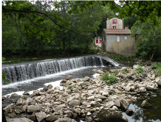
Figure 30 : Chaussée des Epinettes sur la Maine
