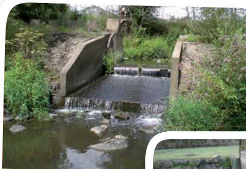
Photographie 30 : abaissement d'un clapet
