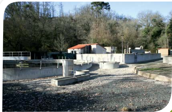
Photographie 21 : station d'épuration
