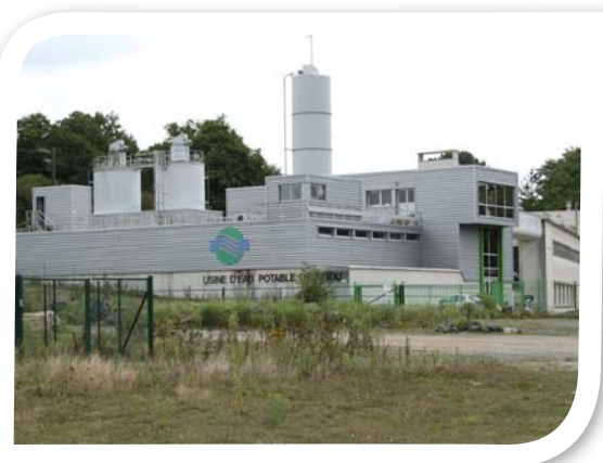
Photographie 17 : usine d'alimentation en eau potable
