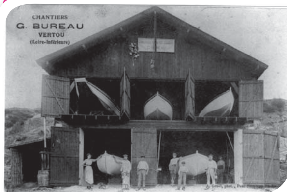
Photographie 25 : chantiers de construction navale
