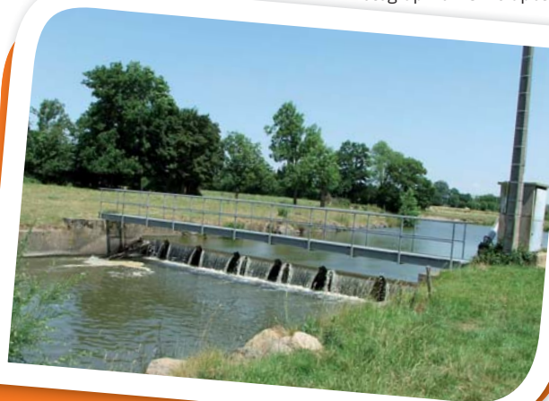
Photographie 28 : clapet
