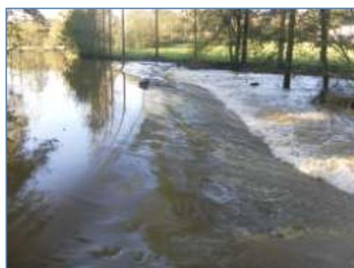
La chaussée fait obstacle aux écoulements et bloque le transit des sédiments, la seule possibilité de transport se faisant par les vannes usinières.
