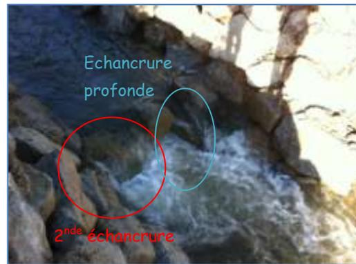
Ce dispositif permettra d'assurer une hauteur d'eau suffisante sur chaque seuil pour le franchissement des espèces, notamment lors des plus faibles débits.
