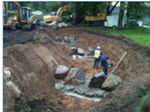
L'ancrage des seuils dans le fond de la passe est un élément fondamental à assurer de manière à éviter tous risque d'affouillement et de déstabilisation.
