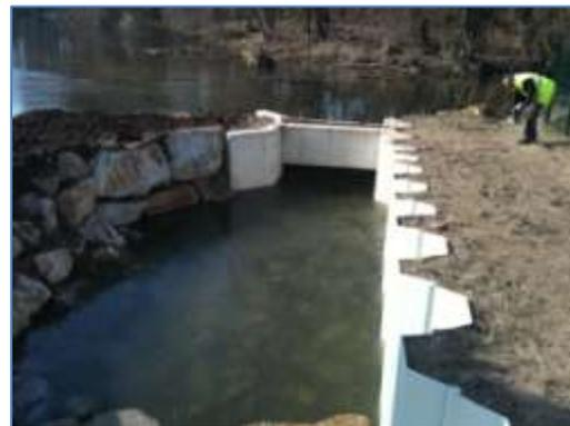
*Exemples de réalisations d'ouvrages d'entonnement (prise d'eau) en béton.*
