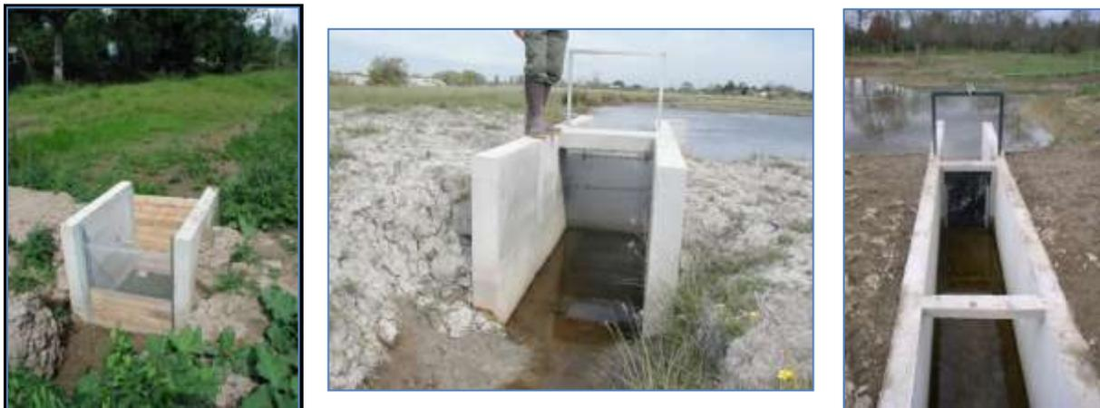
*Exemples de micro ouvrages de régulation des niveaux dans des frayères avec vannette ou batardeaux.*
