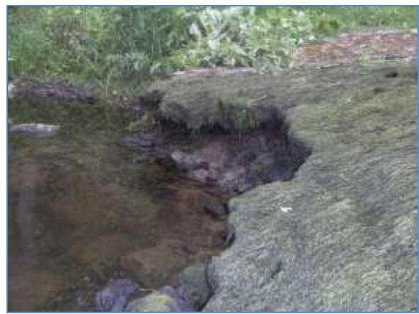
*Dégradations multiples en crête, sur le parement et en pied de la chaussée.*
