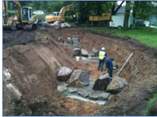
L'ancrage des seuils dans le fond de la passe est un élément fondamental à assurer de manière à éviter tous risques d'affouillement et de déstabilisation.
