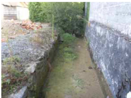
Avant travaux : Partie canalisée, fond et berges maçonnés, lit envasé
