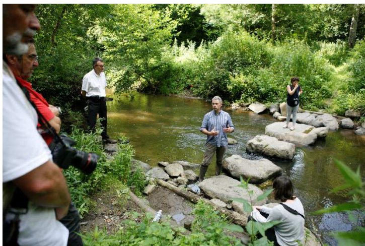
Visite des travaux de restauration de la Sanguèze à Mouzillon lors de la formation sur l'hydromorphologie
