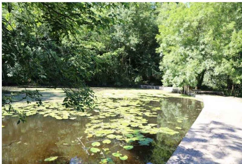
Ouvrage sur le site de la Limouzière à Saint-Georges de Montaigu
