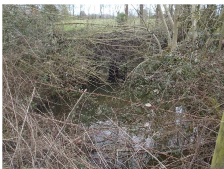
La Digue avant travaux
