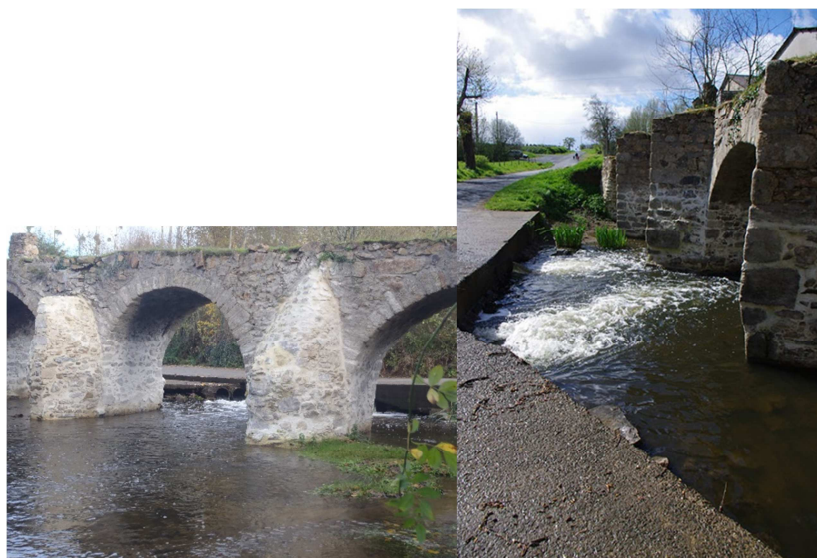
Pont Gallo-Romain et passage routier - vues aval et amont
