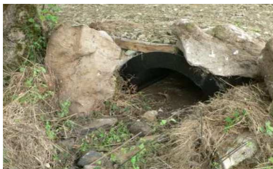
Demi tunnel en PEHD en remplacement d'un passage busé
