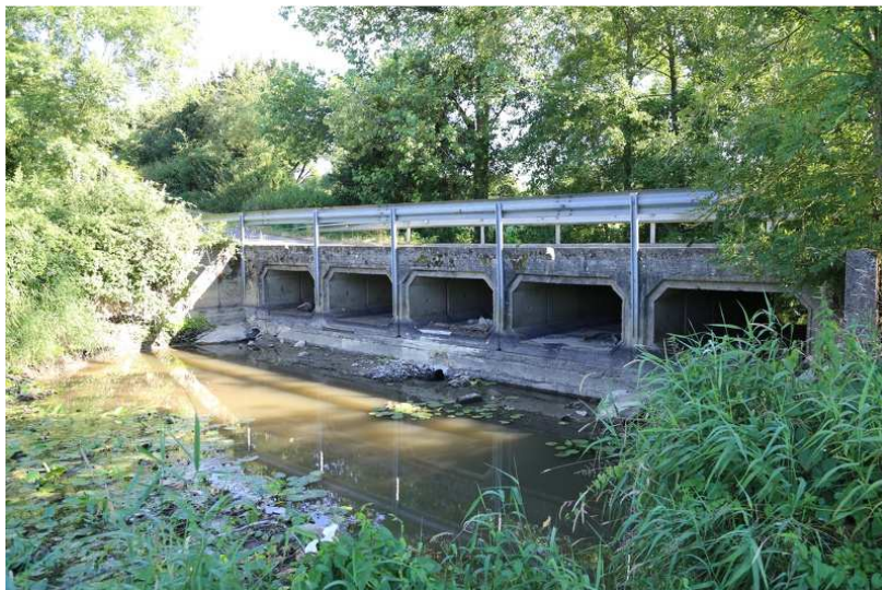
Ouvrage sur le site de la Berthe Landière à Chauché
