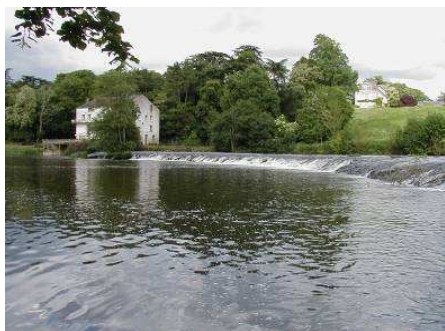
Chaussée du Moulin des Ronces Monnières – Le Pallet
