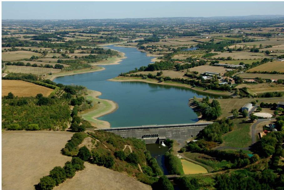
Le barrage de la Bultière sur la Grande Maine à Chavagnes-en-Paillers, Michel Bernard-ECAVAviation / CAUE85.
