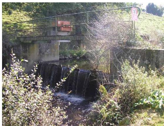
Ouvrage sur le site de la Daunière avant sa suppression
