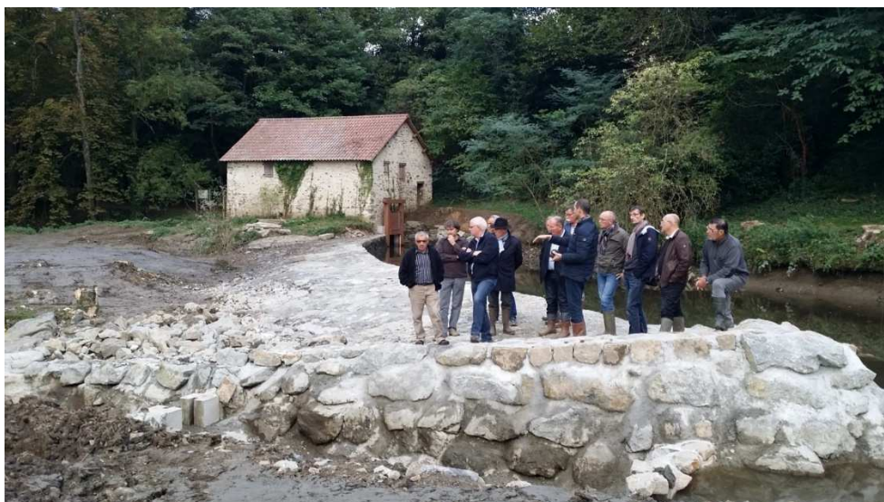
Brèche créée dans l'ouvrage
