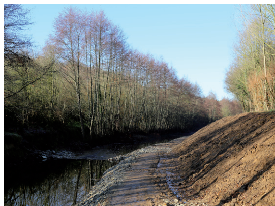
Retalutage des berges et radier à Bikini à Saint-Crespin-sur-Moine (49)
