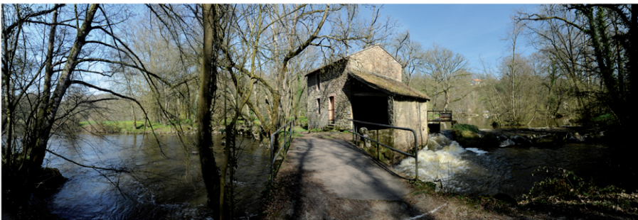
Ouvrage et moulin d'Etourneau à Saint-Laurent-sur-Sèvre (85)
