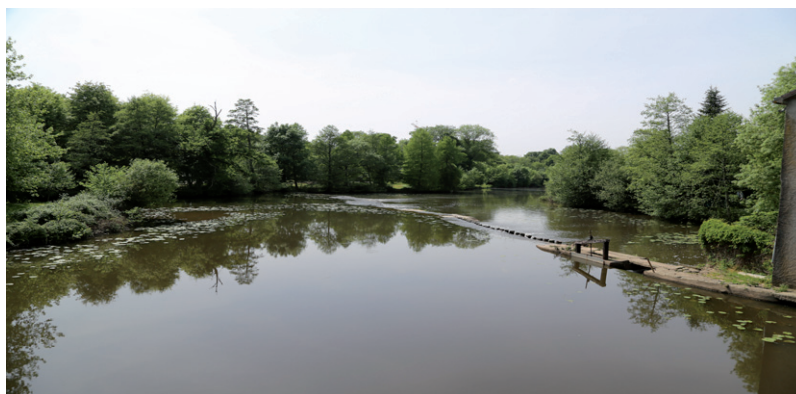
Ouvrage de Pont-Boisseau à Saint-Georges-de-Montaigu (85)
