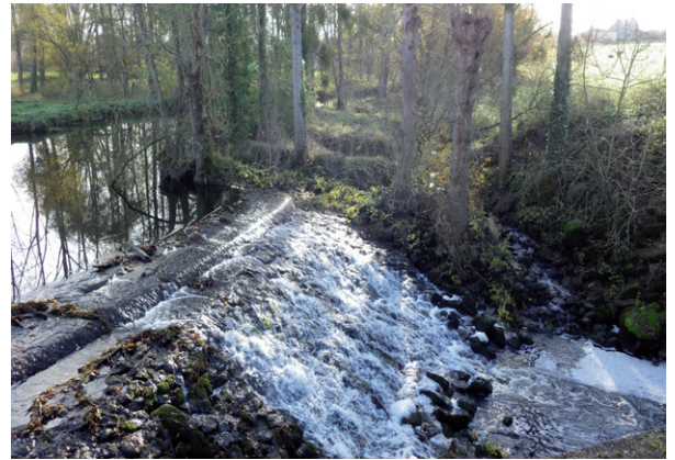
Ouvrage de Bois Chaudeau à Mouzillon (44)
