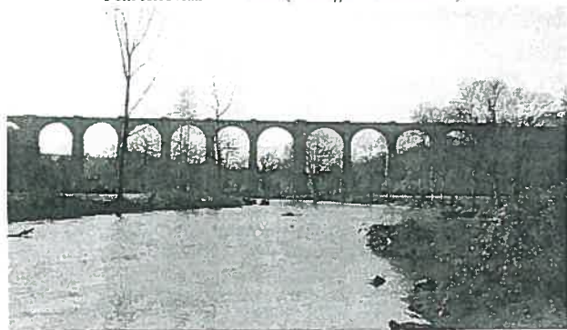
Pont ferroviaire de barbin (Mortagne/Saint Laurent)
