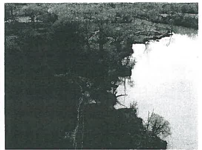
à partir du viaduc ferroviaire côté ouest
