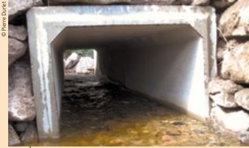
Dalot sur le ru d'Avau (21), avec reconstitution d'un lit naturel.
