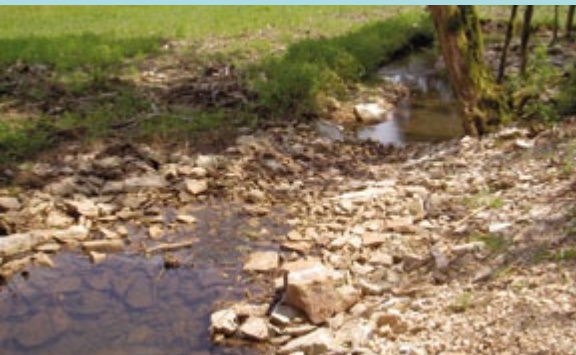
Rampe en pierres plates en "selle à cheval" sur le ruisseau du Merlue (Ecrille, 39), lors de l'étiage prononcé de 2009. Un an après l'installation, les interstices ne sont pas totalement colmatés et l'écoulement peut se faire dans l'ouvrage.
