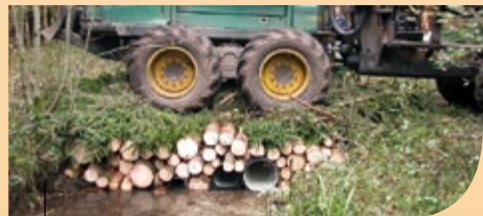
Installation d'un pont de billons avec des tubes PEHD dans le Châtillonnais (21).
