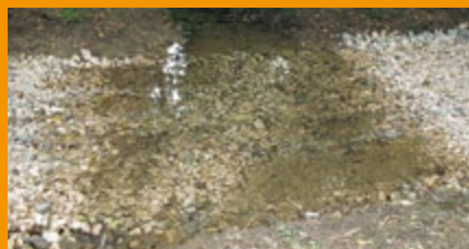
Passage à gué empierré sur un ruisseau temporaire de la forêt de Chaux.
