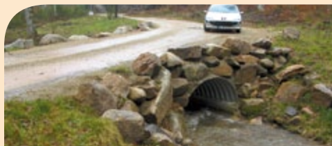
Arche métallique et sur semelle béton dans le Morvan.
