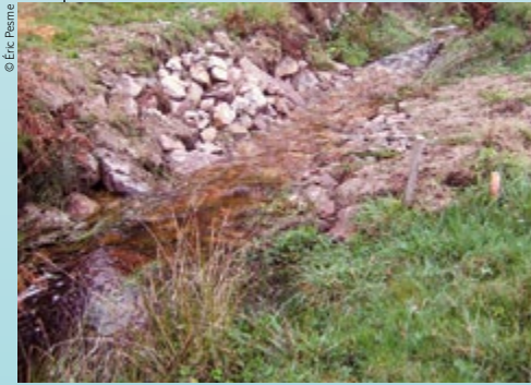
Rampe en pierres granitiques sur le ruisseau de Vaucorniau (Brassy, 58). 23 rampes ont été installées sur 450 mètres.
