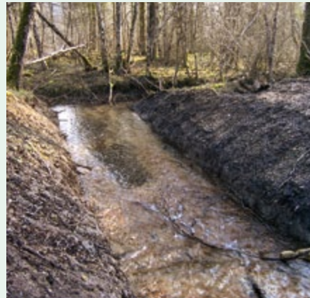
L'ouverture de cette digue est légèrement sous-dimensionnée, la restauration complète du ruisseau sera plus longue.
