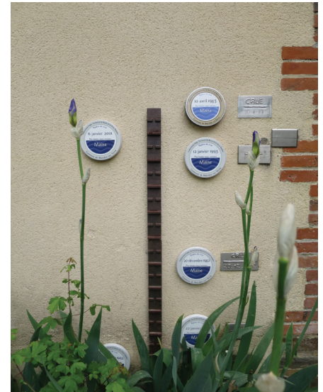
Repères de crues sur le site de Pont-Caffino à Maisdon-sur-Sèvre (44)
