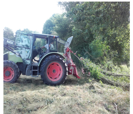
Travaux de la ripisylve sur le bassin du Marchais à Courlay (79)
