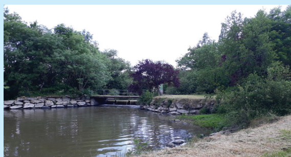
Travaux sur le site de Moulin Neuf à Saint-Jouin-de-Milly (79)
